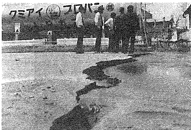
(写真-12-3) 地盤の亀裂
