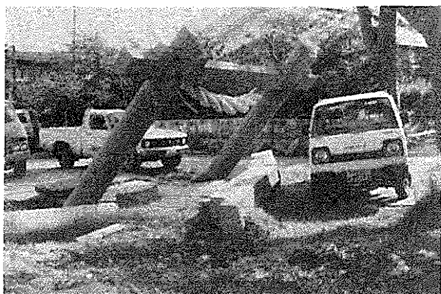
◀ 鳥居の倒壊状況（秋田市青葉町）
