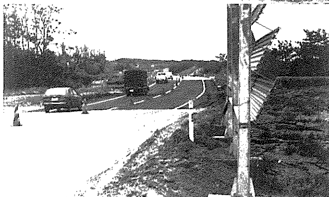
◀ 液状化により被害を受けた道路の 応急復旧状況 (能代市、国道7号バイパス 浜浅内付近)
