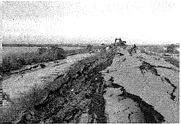
▲ 五明光橋西側道路の沈下崩壊状況(若美町)
