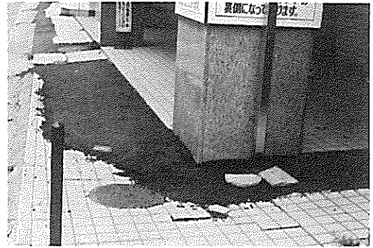
▲ 幅約20cmのき裂が復旧されている (秋田市大町2丁目 本金デパート)
