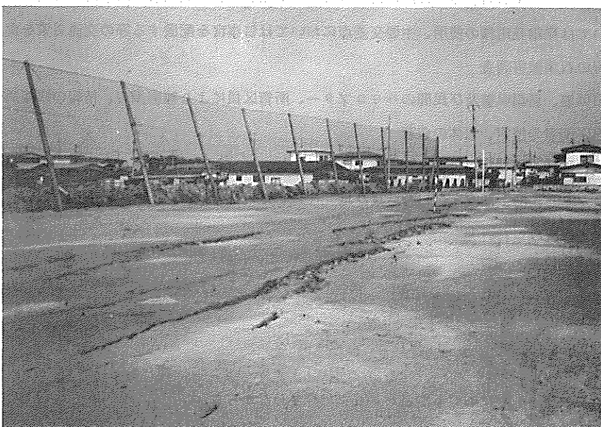
亀裂が生じた運動場、傾いた掲揚塔 （男鹿市内の高等学校）
