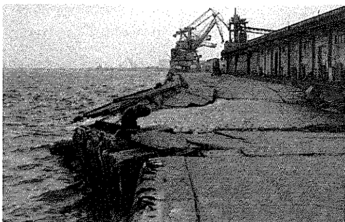
◀ 秋田港中島1号上屋 前面岸壁（秋田市）
