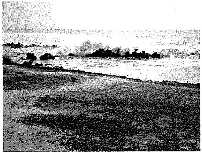
59 峰浜海岸の飛散した消波ブロック(2 tブロック)
