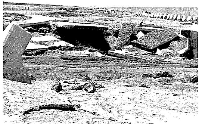
61 峰浜海岸堀川北側 写真右側にH=3.65mの護岸と後方根固ブロック(ホロスケーヤ)の飛散(約140個)
