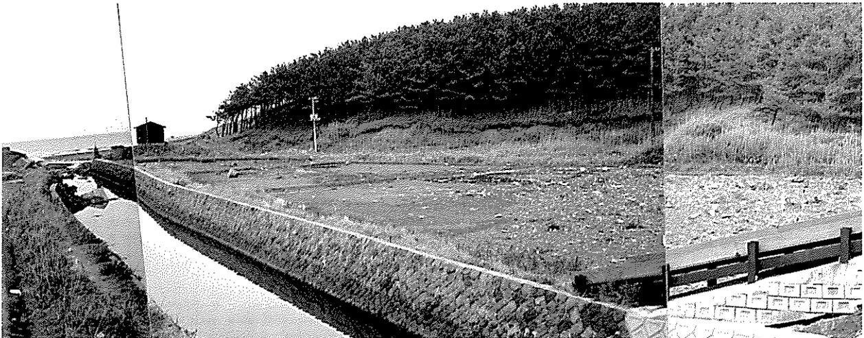
65 峰浜海岸の目名潟地区 H=4.70mの護岸が倒壊して背後が侵食されている (保安林施設)
