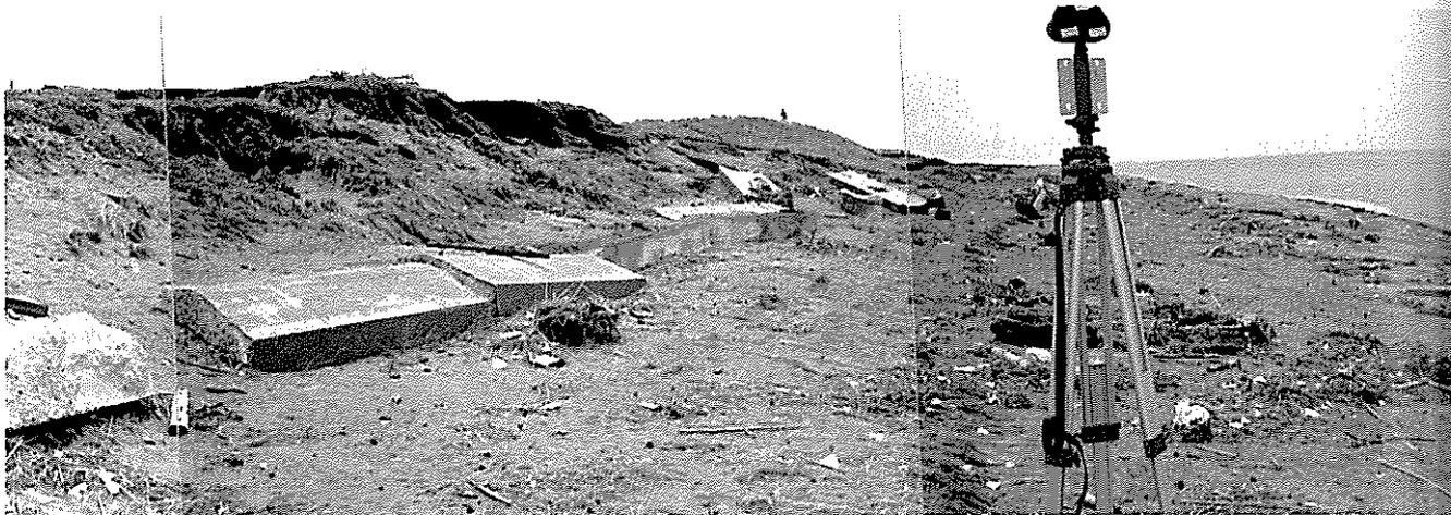
66 八竜海岸釜谷地区の飛散した消波ブロック (海岸保全施設)
