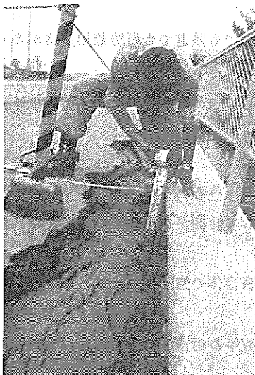
東北自動車道切盛境界クラック (補修状況)
