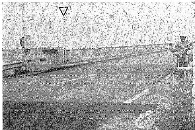
右岸取付道路
