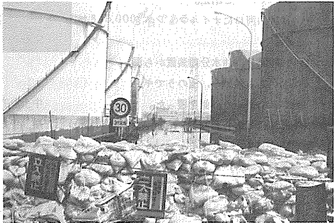
重油が流出した仙台製油所溝内の状況
