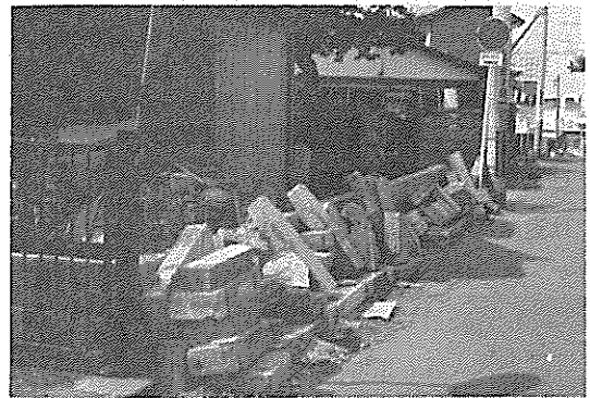
大谷石塀の倒壊状況
