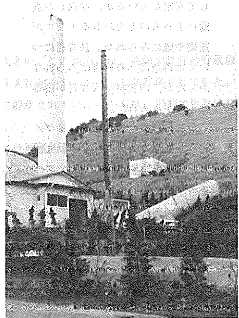
東伊豆町 ごみ焼却場
