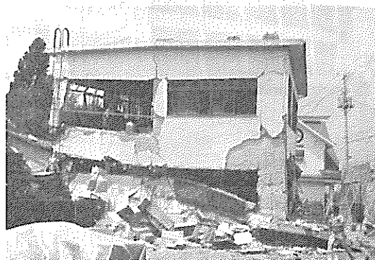
パロマ仙台営業所 昭和30年建設
