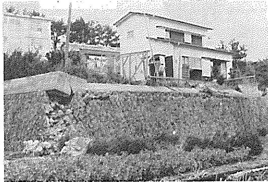
東伊豆町熱川 盛土宅造地の擁壁
