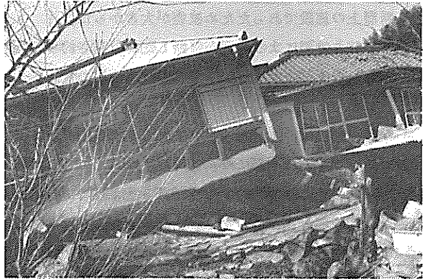
河津町梨本 県道修善寺一下田線下の倒壊した民家
