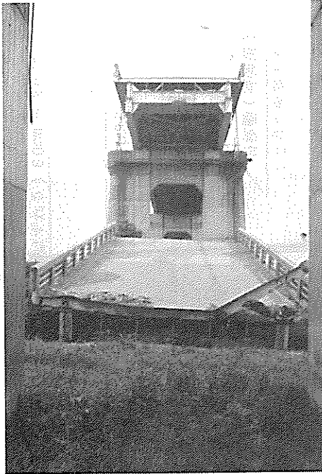
錦桜橋 落下柵
