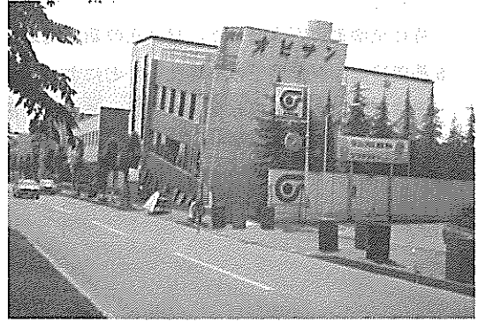
倒壊した3階建オヒサンビル
