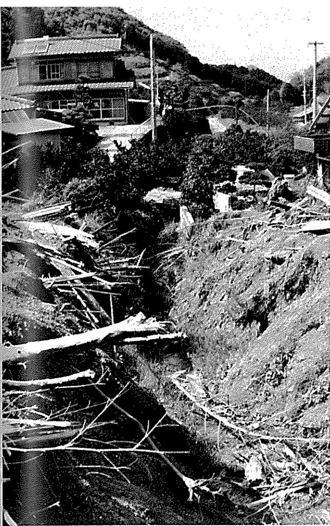
土砂流入と激流で水路損壊(後川内)
