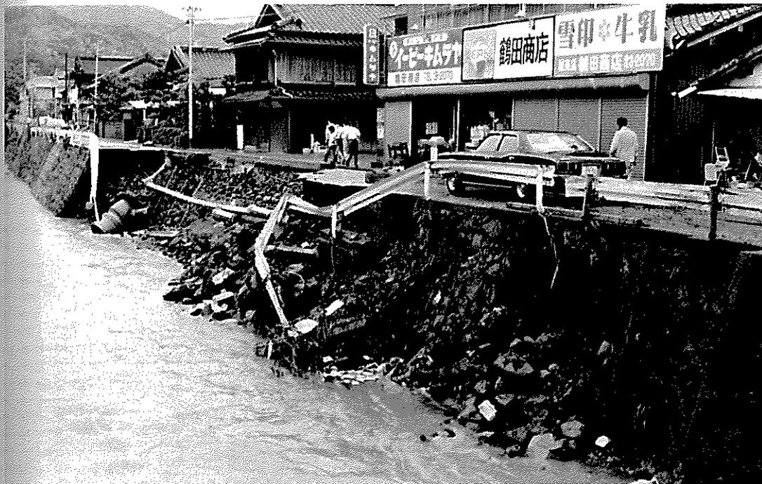
道路が大きく崩れ下水管渠が流失(井手本)
