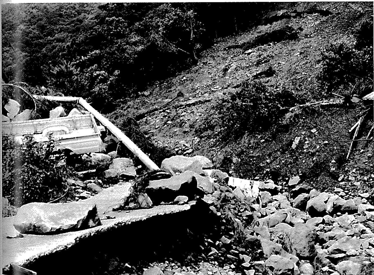
山崩れは家を押つぶし、電柱をへし曲げ、滝のような水は道路を根元から洗った。(枯木尾)
