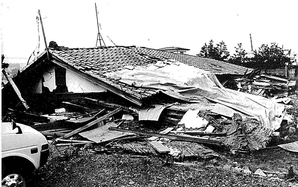
倒壊した住家 老朽家屋や地盤の悪い所の家屋に被害が集中 (米山町)
