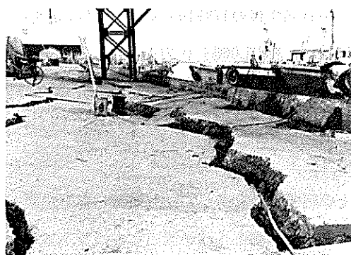
地割れを起こし崩れかかった関上漁港（名取市）
