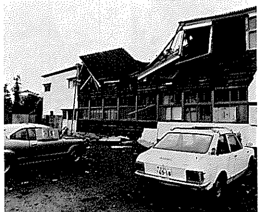
倒壊し、使用不能になった野村小学校（泉市） 被害を受けた学校では体育館や、プレハブ校舎で授業を行っている。
