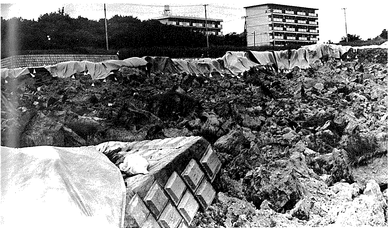
地滑りのため崩壊した造成中の白石市寿山団地 —約13万立方メートルの土砂が流出—
