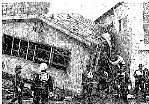
倒壊した家屋の撤去作業。(迫町) 多くの市町村で消防団、住民の救援活動が展開された。
