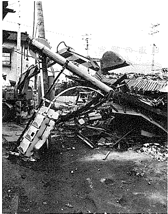
倒壊した信号機 信号機の倒壊、滅灯で交通が混乱した。
