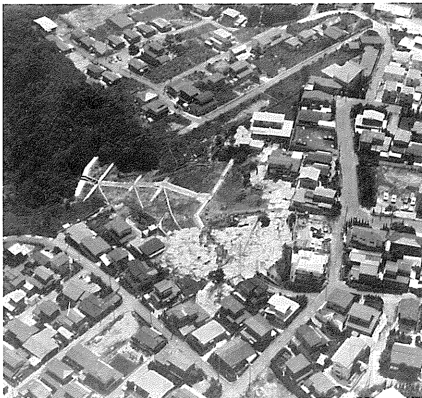
宅地被害で、最大の被災地となった緑ヶ丘団地（仙台市）中央にあるのは、旧蛇沢の砂防指定地内の砂防ダム
