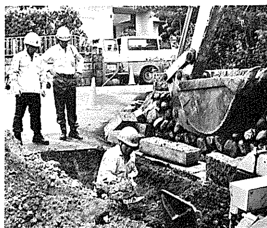
安全性を確保しながら慎重に進められたガス復旧作業、 全国から多くの応援がかけつけた。（仙台市）
