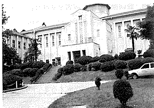
建物内部の損傷がひどく、使用不能となり、建て替えが必要となった児童福祉施設小百合園（仙台市）
