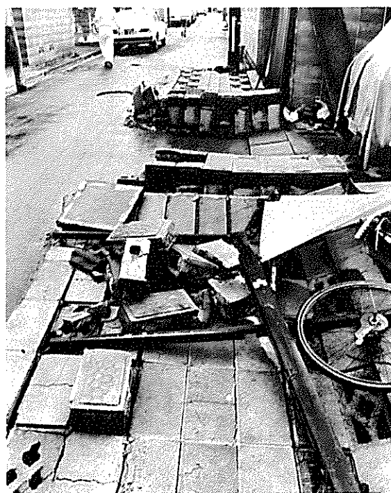
県内いたるところで倒壊したブロックべい(仙台市内) 写真 河北新報社提供
