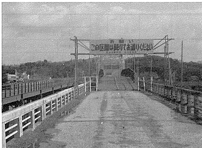
落橋した錦桜橋（手前）に、約6億円を投じて仮橋（向こう側）を設置、11月1日から通行可能となった。
