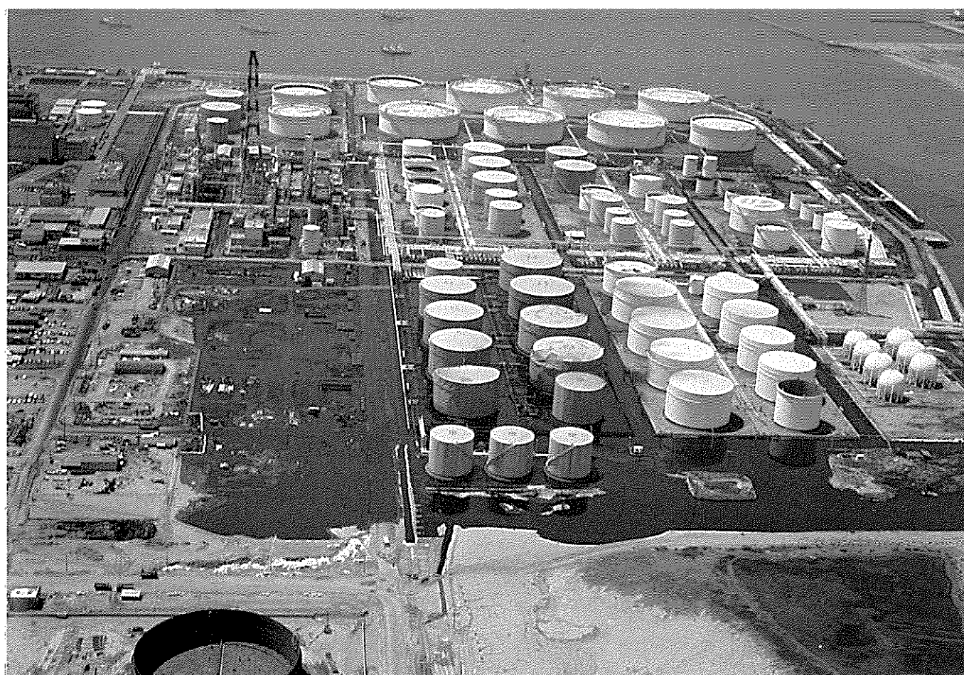
オイルタンクが破損し、大量の油が流出した東北石油㈱（仙台港）
