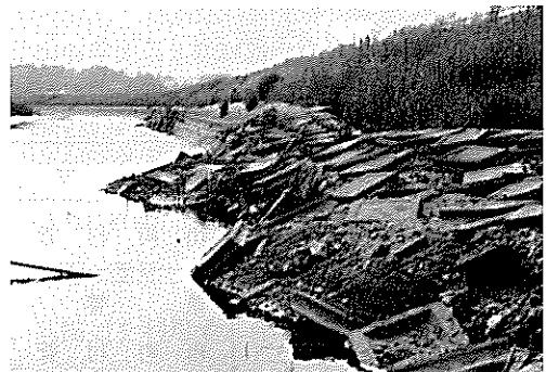
河川堤防が亀裂、沈下し、護岸の平張ブロックの崩壊した定川（河南町）
