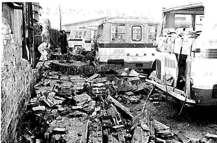
レンガ塀が倒壊して駐車場のバスを直撃（北奥新報社 撮影）
