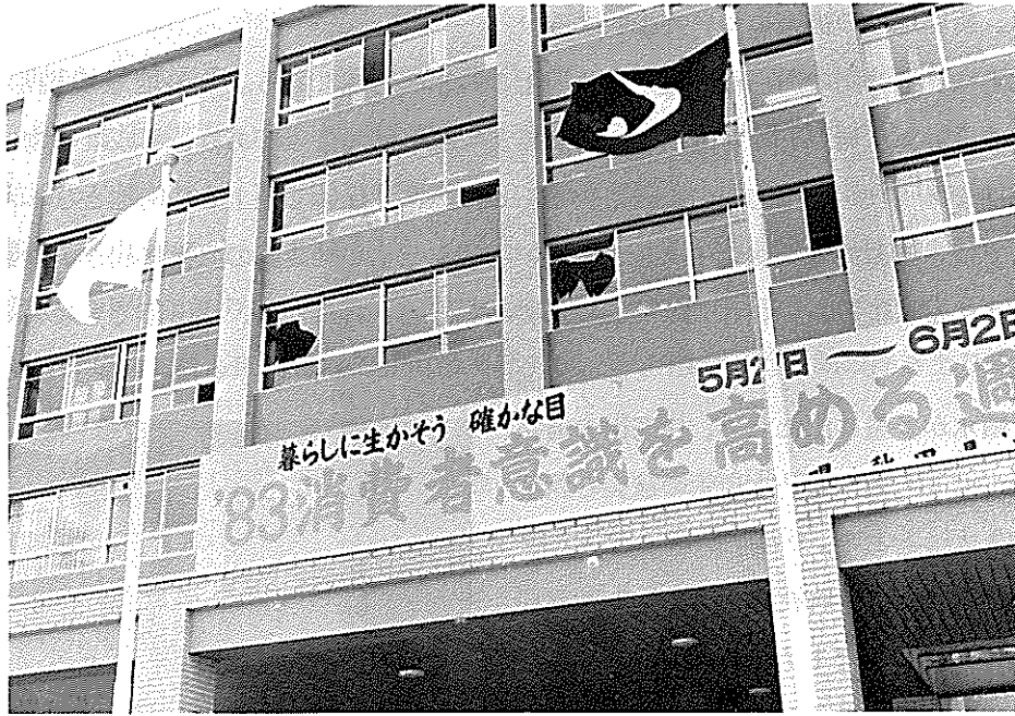
県庁舎の窓ガラスが割れた（全部で604枚）
