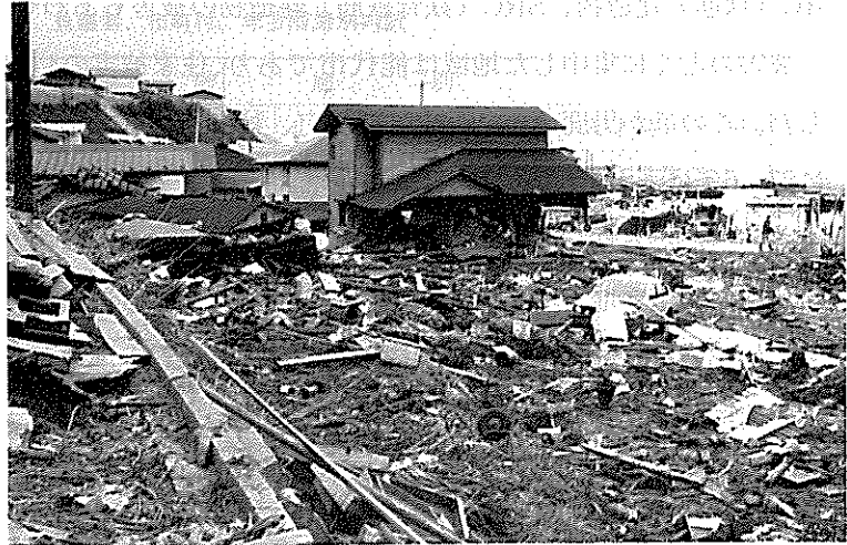
津波による住宅被害（八森町）
