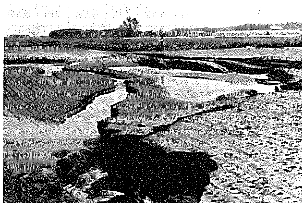
地盤の表層移動と陥没した水田（若美町）
