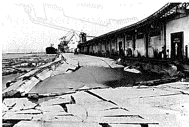
秋田港中島埠頭の被害、315tアンローダーも使用不能
