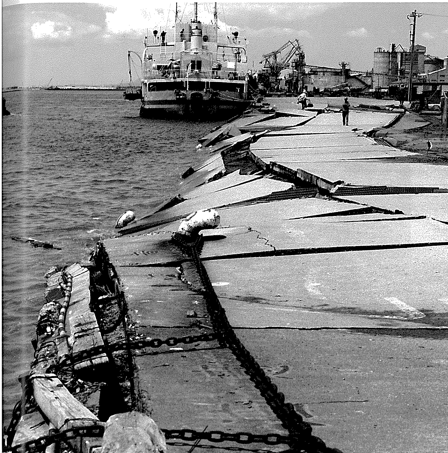
地震動と液状化により岸壁がズタズタとなり、機能がマヒした秋田港
