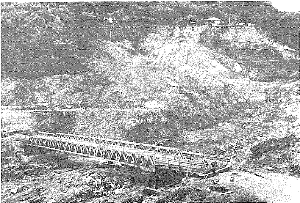
大又川に架った仮設橋
