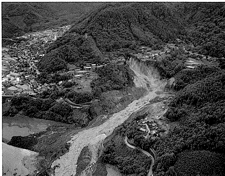
松越地区土砂崩壊全景
