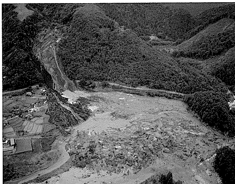
滝越地区土砂崩壊全景
