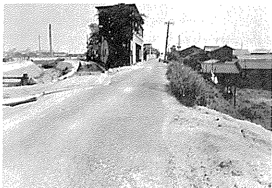
決壊すると大変なことになる 高川の天井川風景 (堤防の高さ6m (豊中市豊南町東2丁目))
