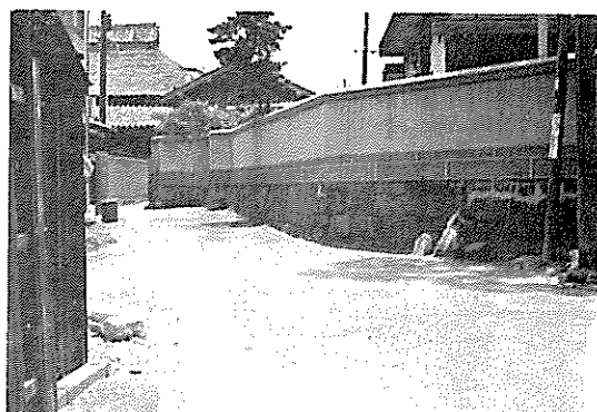
石垣で洪水に備えた自然堤防土 の古い民家 (豊中市大島町1丁目)
