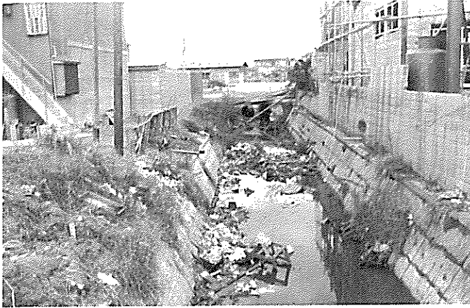
塵埃で埋まり、昭和 42 年 7 月豪 雨における庄内地区の浸水被害を 激化する原因となった農業用水路 （ 豊中市二葉町 2 丁目 ）
