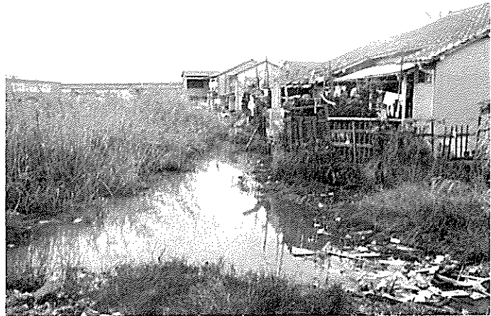
乱雑な住宅の進出で流出道を失っ た農業用水路 （ 豊中市二葉町 1 丁目 ）
