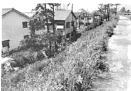
荒廃寸前の天竺川の天井川風景 (豊中市稲津町5丁目)
