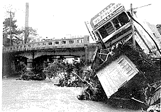
7月豪雨で倒壊した箕面市の商店 (箕面市桜ヶ丘)
