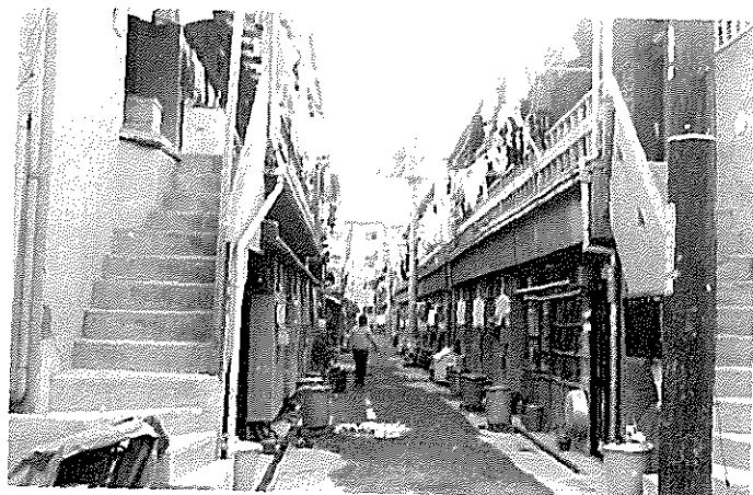
内水洪水の原因となることを知っ てか知らずか乱雑に立ち並んだ 豊中市庄内の住宅街風景 （豊中市庄内栄町付近）
