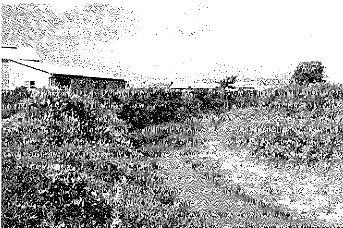
折角改修されながら河床は雑草で 埋まり昭和 42 年 7 月豪雨の被害 を激化させた千里川下流の河床 （ 豊中市勝部東町 ）
