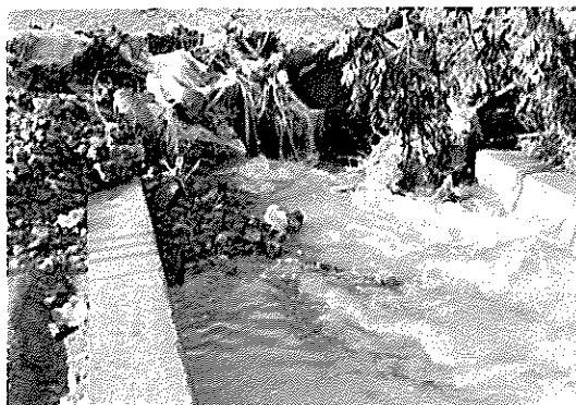
流木、土砂による埋没寸前の荒堀川の 暗渠（池田市緑ヶ丘1丁目、大阪教育 大学付属中高校グラウンド付近）
