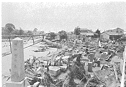
7月豪雨による堤防流失で荒廃した 麻田・箕輪共同築地付近 (豊中市葦池南町2丁目)
