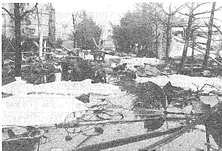
写真－1 発災施設北側の中央道路付近飛散物等の状況
