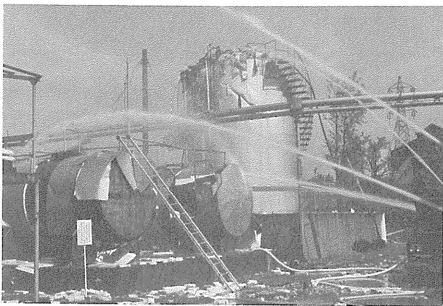
写真－4 AN及びSTタンクの被害状況
