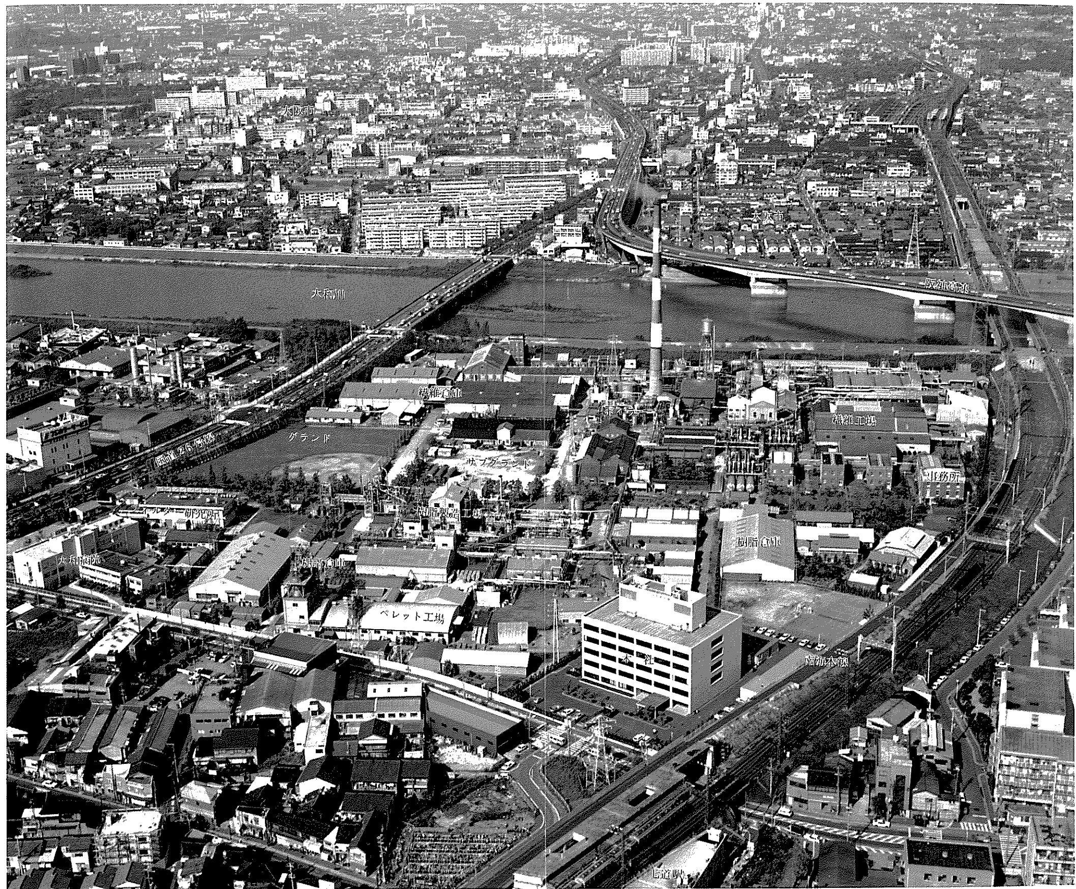
ダイセル化学工業(株)堺工場の全景写真
