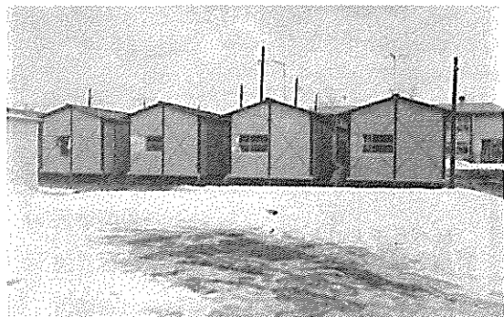
専修訓練校跡地の仮設住宅
