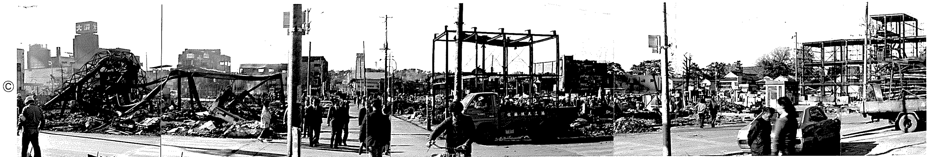
商店街（中町地区）の被害状況
