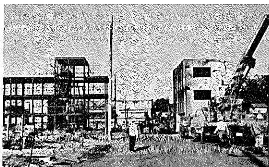
(左) 建設中の鉄骨造 (右) 配電工業
