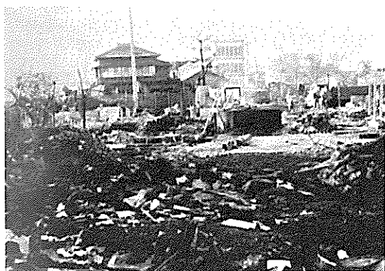
破壊消防により半焼した家屋と残材
