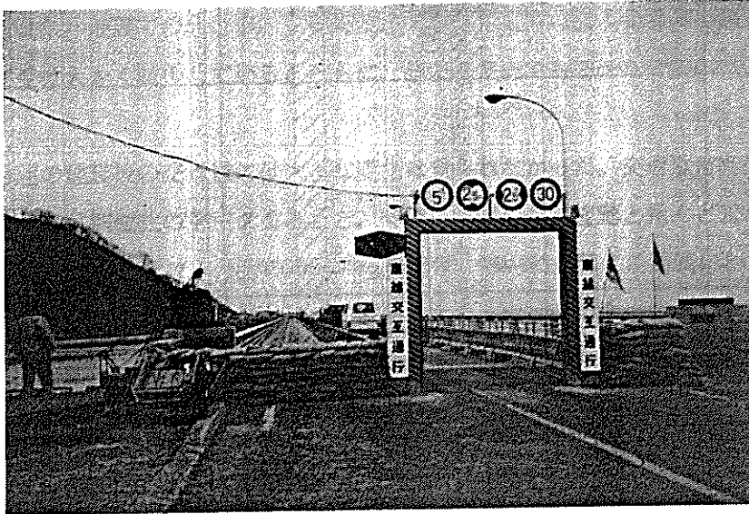
写真－3.1 静内橋交通規制状況
