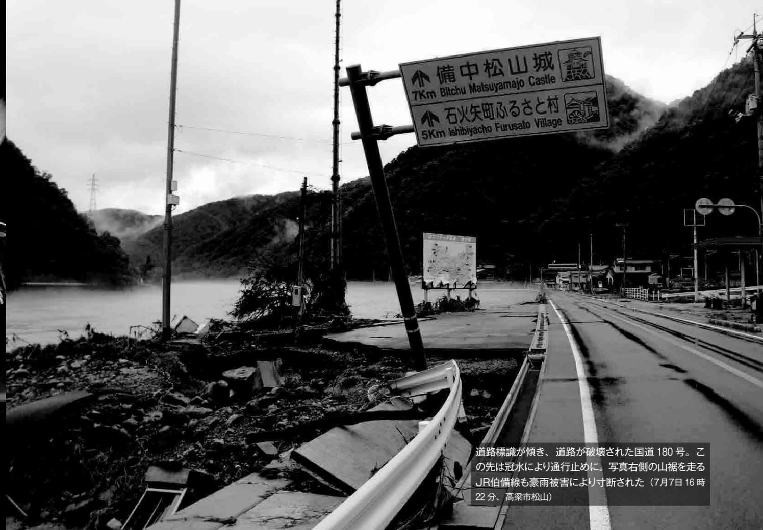
道路標識が傾き、道路が破壊された国道180号。この先は冠水により通行止め。写真右側の山裾を走るJR伯備線も豪雨被害により寸断された(7月7日16時22分、高梁市松山)
