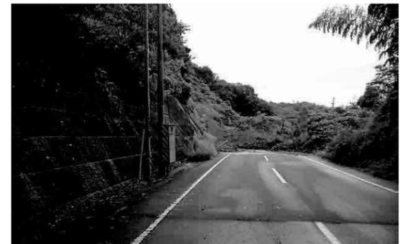
法面保護工破損状況（玉野市滝）
