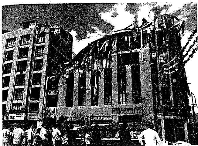
◀ 崩壊したメキシコ市内のビル
