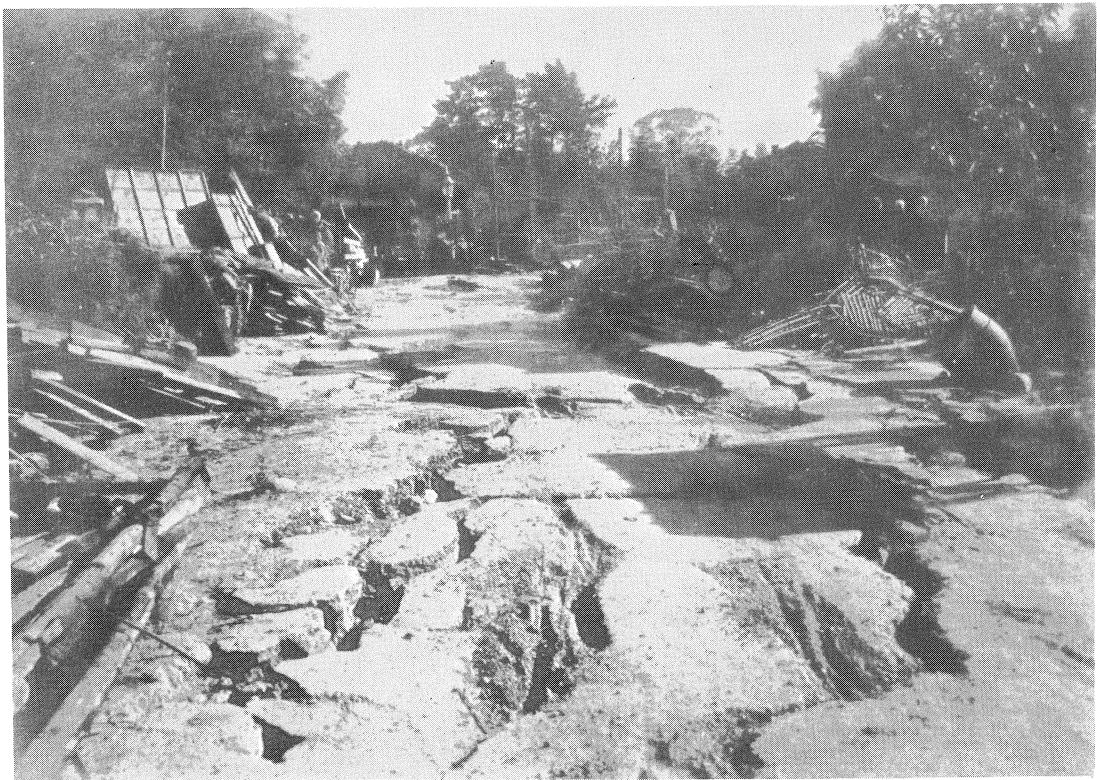
圖ノ壞破路道及災震村方北郡栗葉
