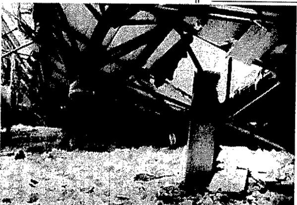
倒壊した今津町の体育センターの内部。天井の鉄骨が崩壊し、床が陥没している。周囲には雪が積もっている。
