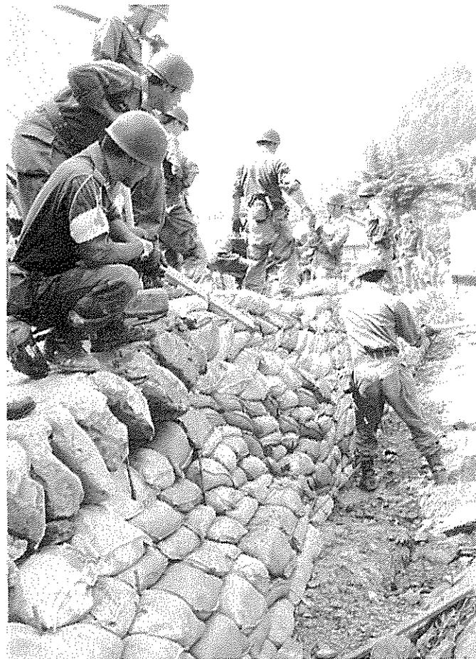
◀決壊した護岸を土のうで補強する自衛隊員 (西吉野村和田)
