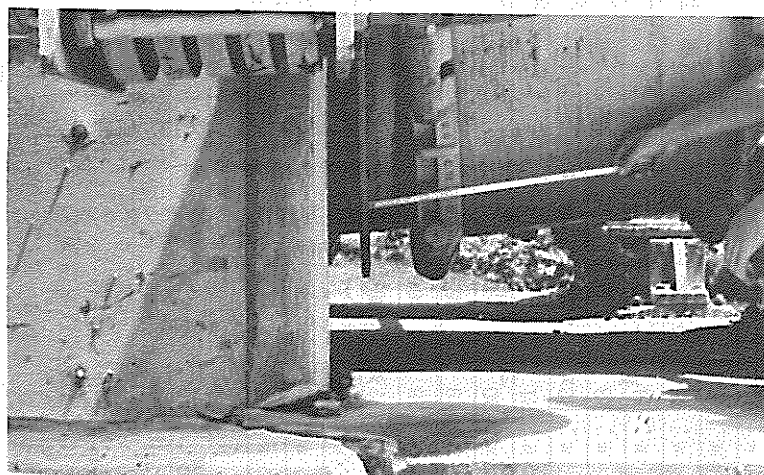
振動によって ズレた伸縮管部 (高砂水管橋)
