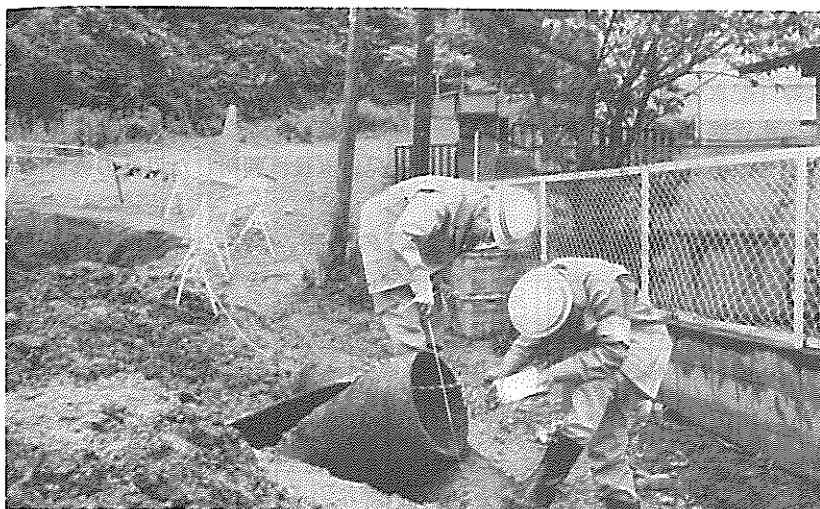
破損した口径 400耗鉄鉄管(大 年寺山系配水本 管)
