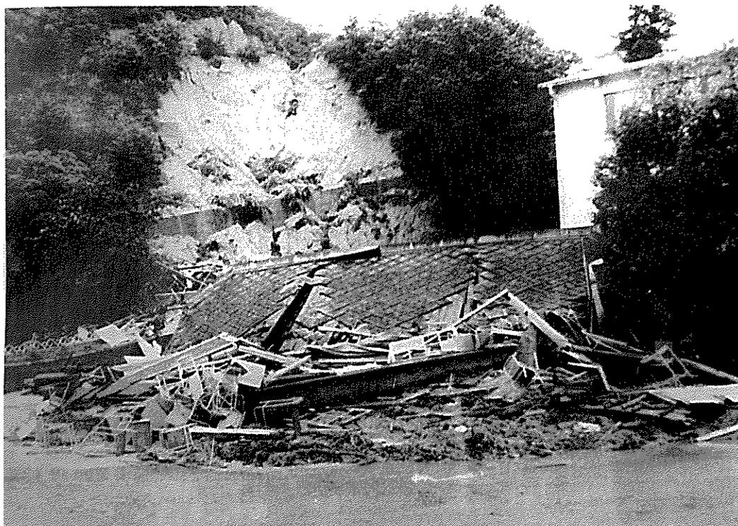
山腹崩壊で倒れた校舎 — 高梁市伊賀町，順正短大
