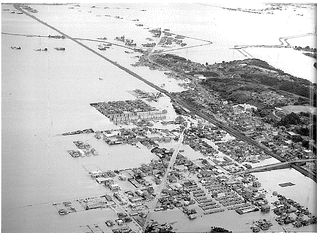
④ 鹿島台町中心部の浸水状況（建設省東北地方建設局北上川下流工事事務所提供）
