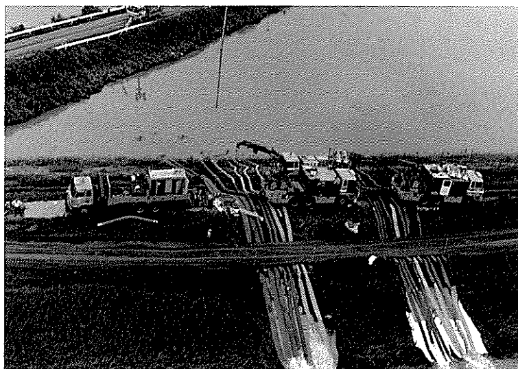
18 松島町内浦地区の排水作業
