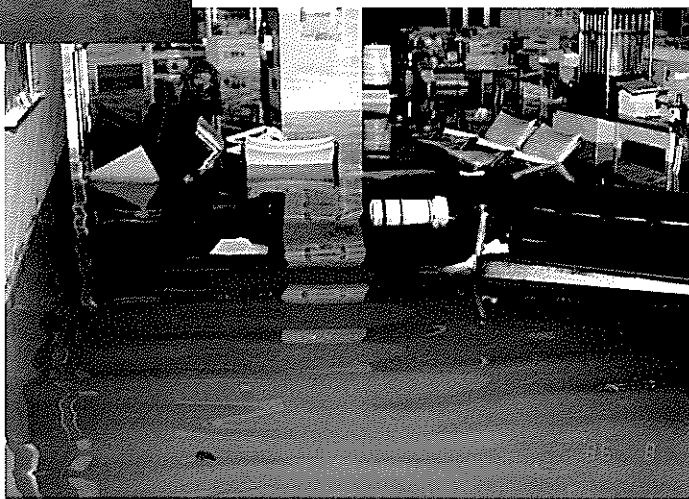
⑫ 卸商団地内にある卸会社事務室の冠水状況 (仙台市)
