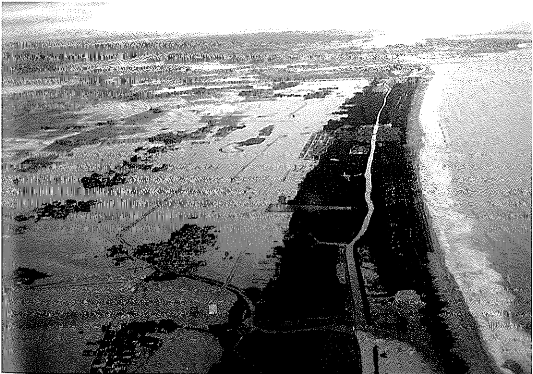
③ 仙台市東部の冠水状況（建設省東北地方建設局仙台工事事務所提供）
