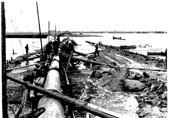
ポンプ船で仮縮切堤補強中
