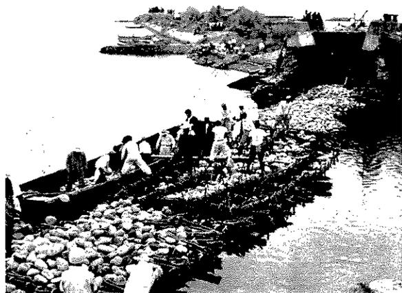
粗朶沈床の上に玉石を投入
