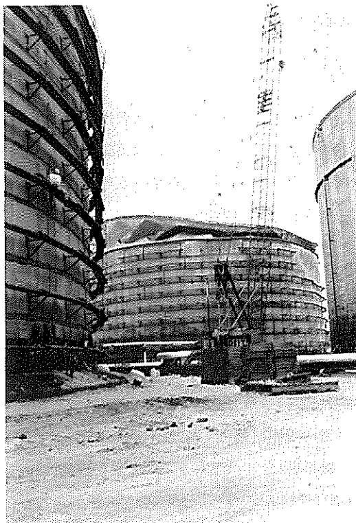
C-4地区 タンク解体作業状況
