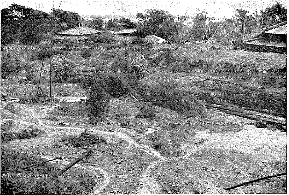
一宮町東浪見の崩壊状況
