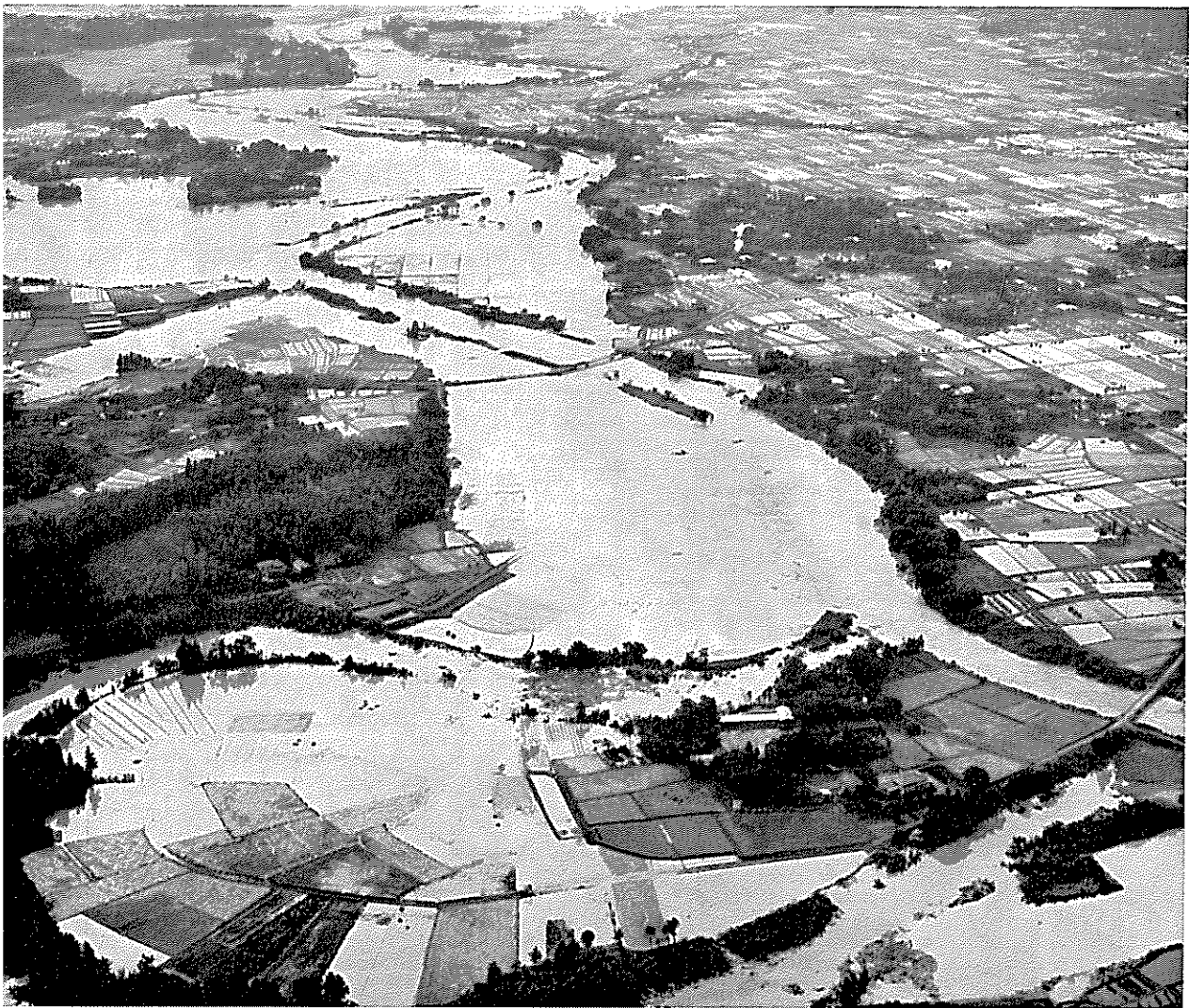
小櫃川土器付近の氾濫
