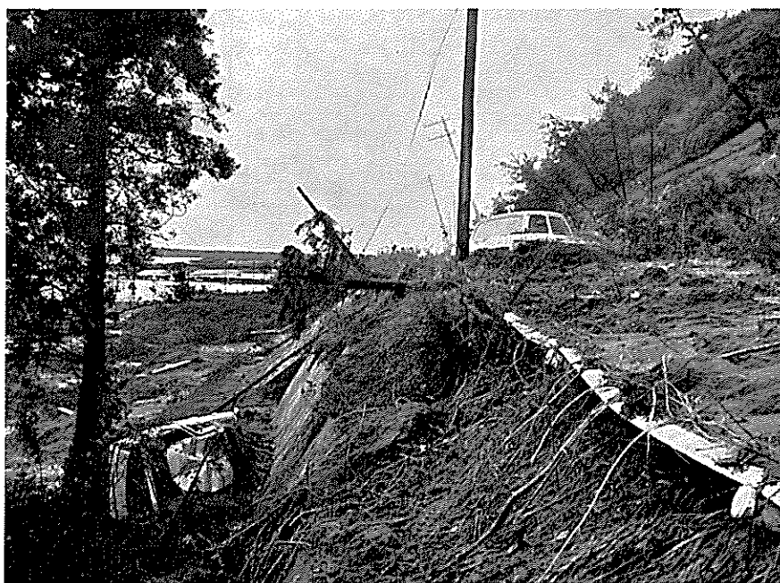
銚子佐原線の崩落土箇所（小見川町長山）、写真右は県道銚子佐原線、道路下は埋没した国鉄成田線
