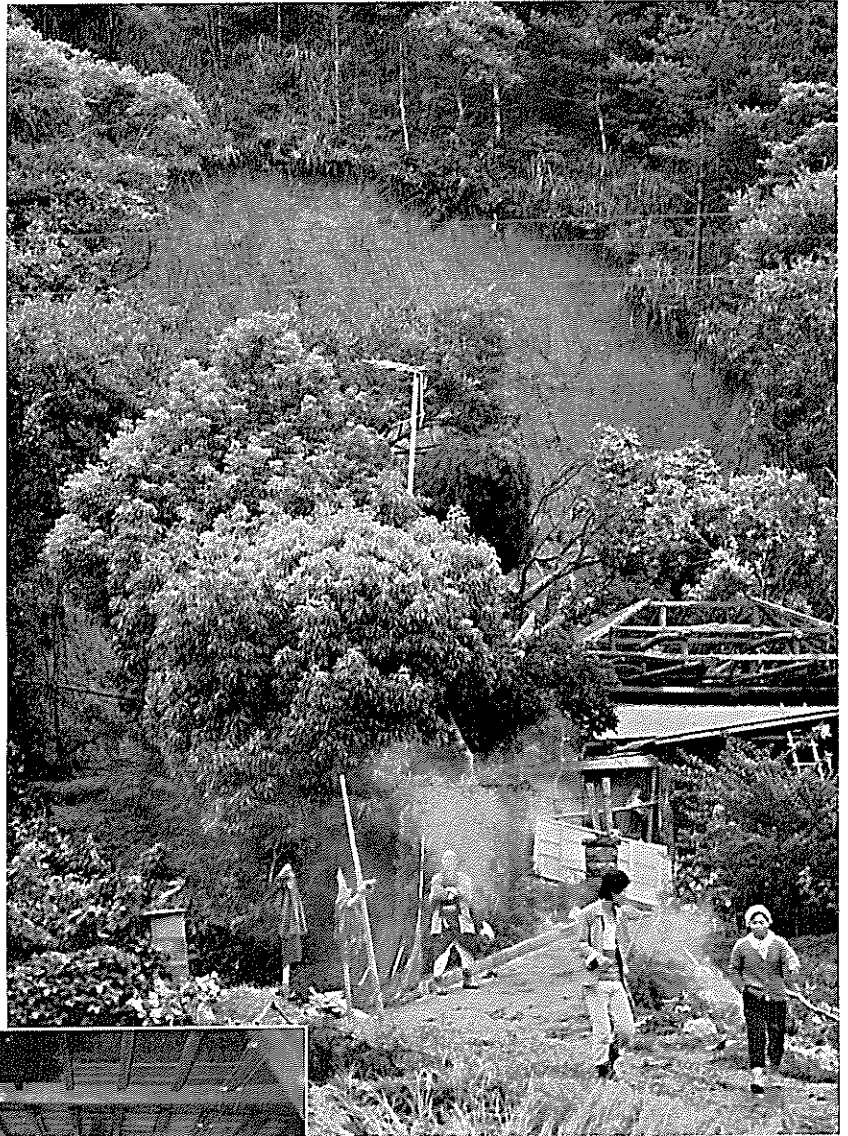
光町市野原のがけ崩れ，家屋倒壊（3人死亡）
