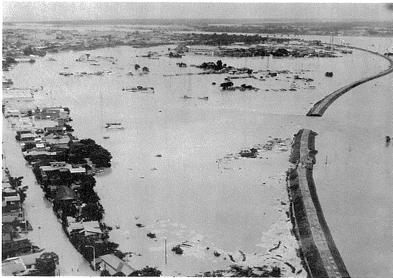
米代川堤防の破堤により濁流が市内をおそった。(能代市中川原)
