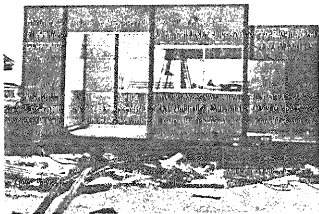
仮設簡易ハウスの建設状況
