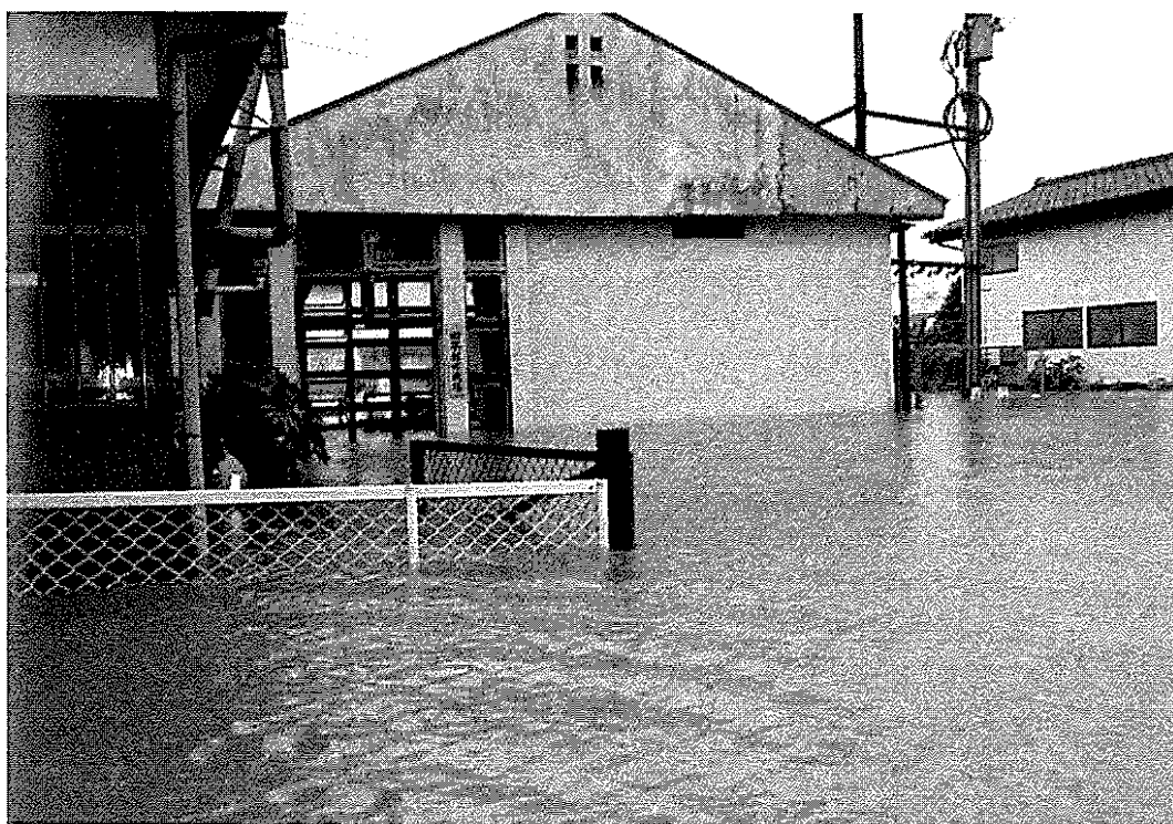
▲ 福田町田子排水機場前の冠水
