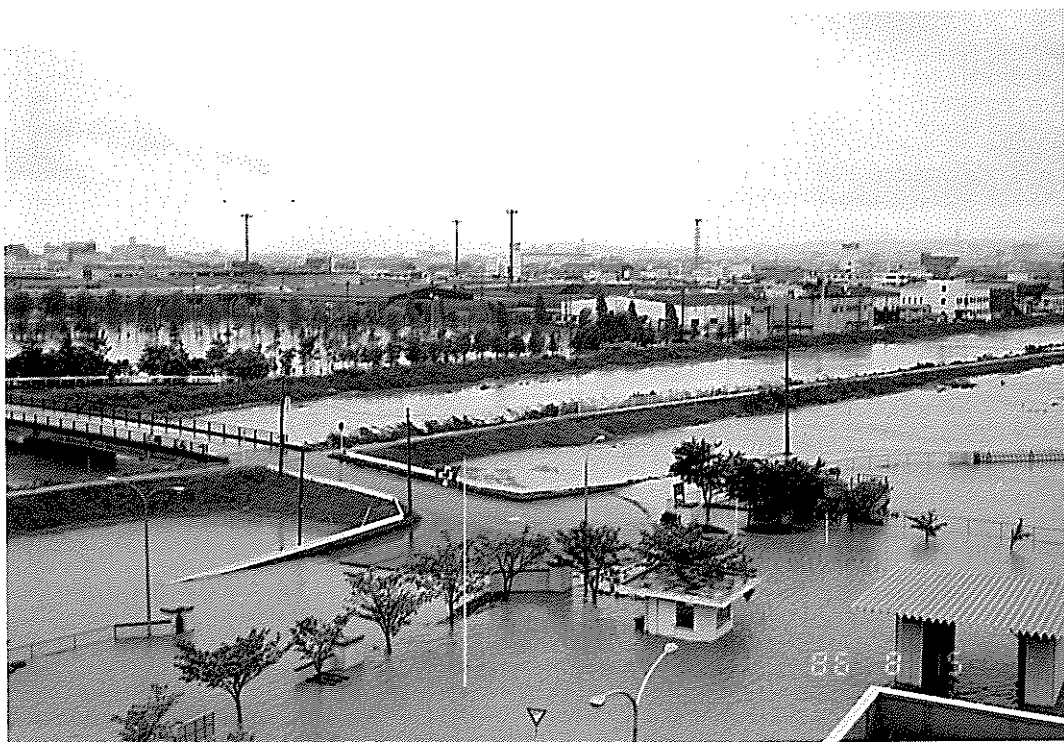
▲ 小鶴清掃工場から見た日の出町方面の冠水
