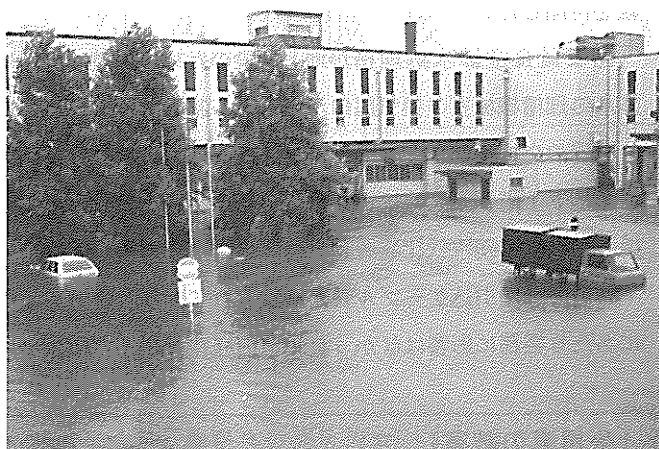
と畜場棟プラットフォーム冠水寸前
