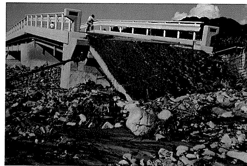
取付部堤防が流失し、無残にこわされた下八町上橋。(下八町)
