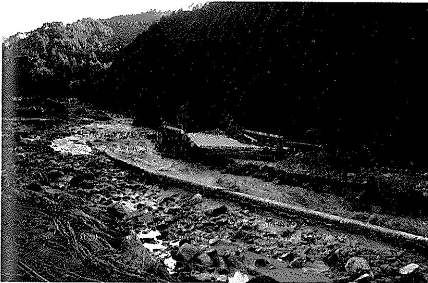
500m近くも流された瀬之脇橋（コンクリート製長さ29・1m幅4・6m）（仁礼町）
