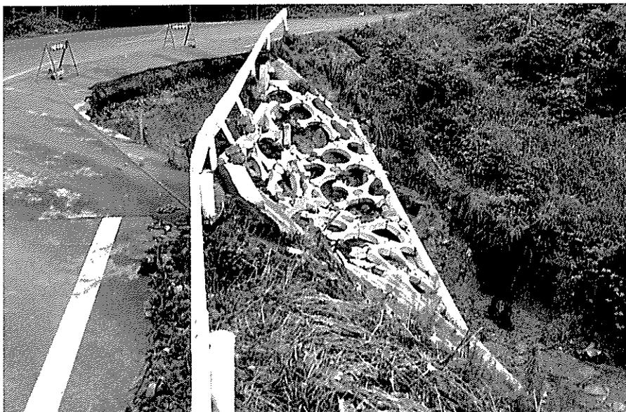
▲暗渠がつまり、道路を濁流が横断したため道路が欠壊（町道古場三本松線平古場名付近）
