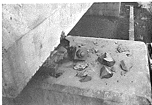
写真V-3-12 支承の破壊
