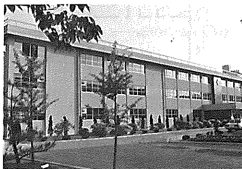
写真IV-7-2 A棟復旧工事後北立面
