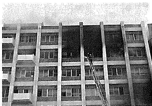
写真IV-5-3 化学実験室の火災 (東北大学理学部)
