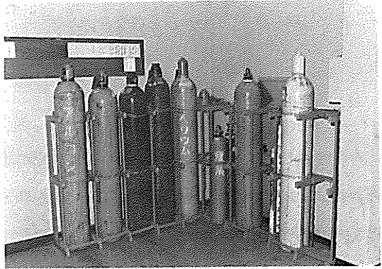
写真IV-5-5 ポンベの固定 (東北大学理学部化学科)
