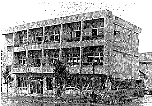
写真IV-2-3 鉄筋コンクリート造3階建物の崩壊（Mビル）
