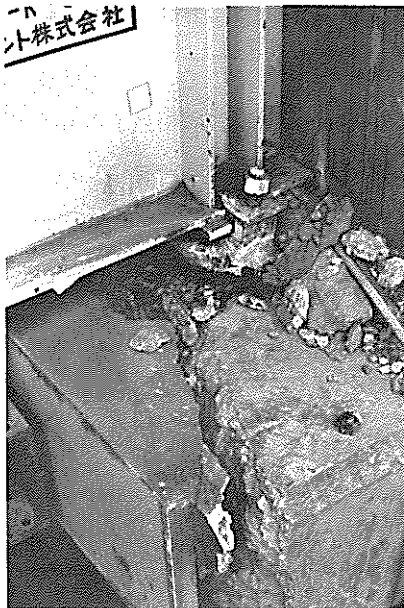
写真V-3-18 桁座の割裂
