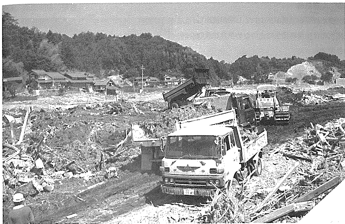
小野河川敷にはトラックで次々災害ごみが運ばれた
