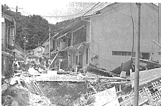
陥没した県道岡見停車場線
