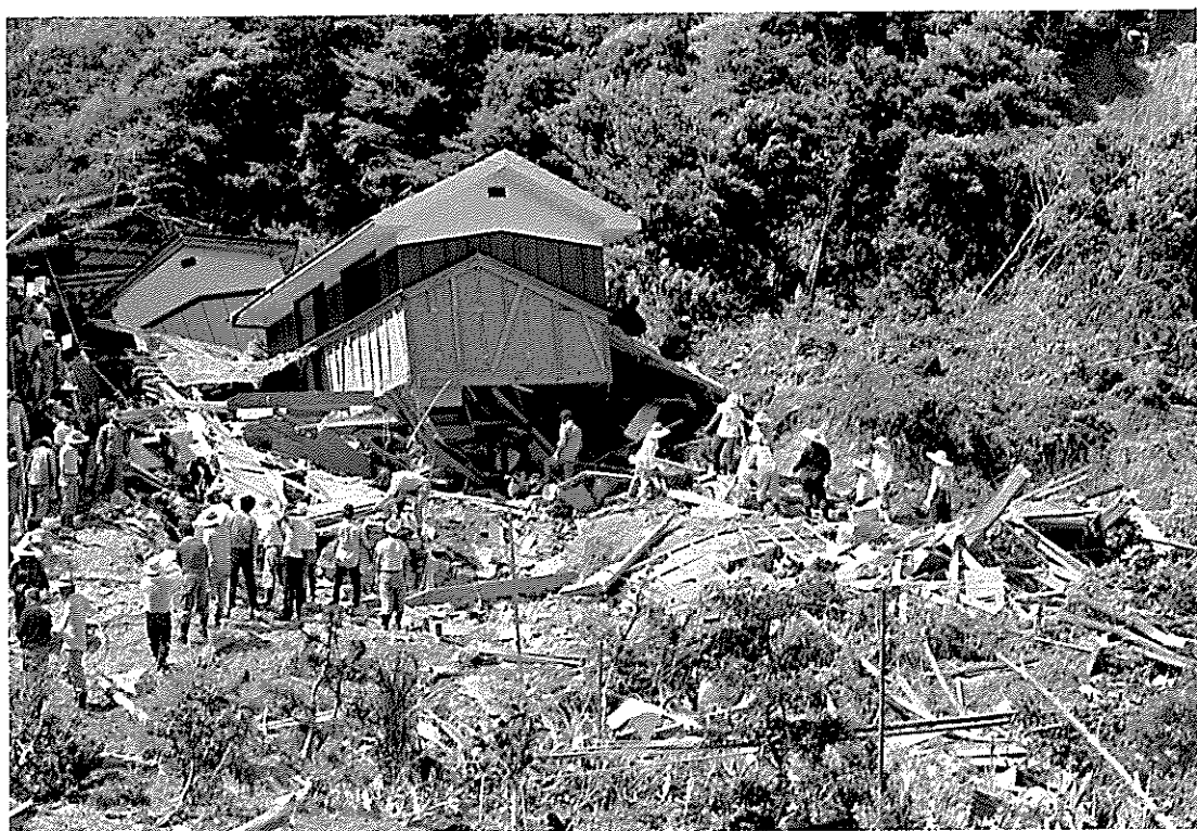
がけ崩れにより崩壊した住宅
