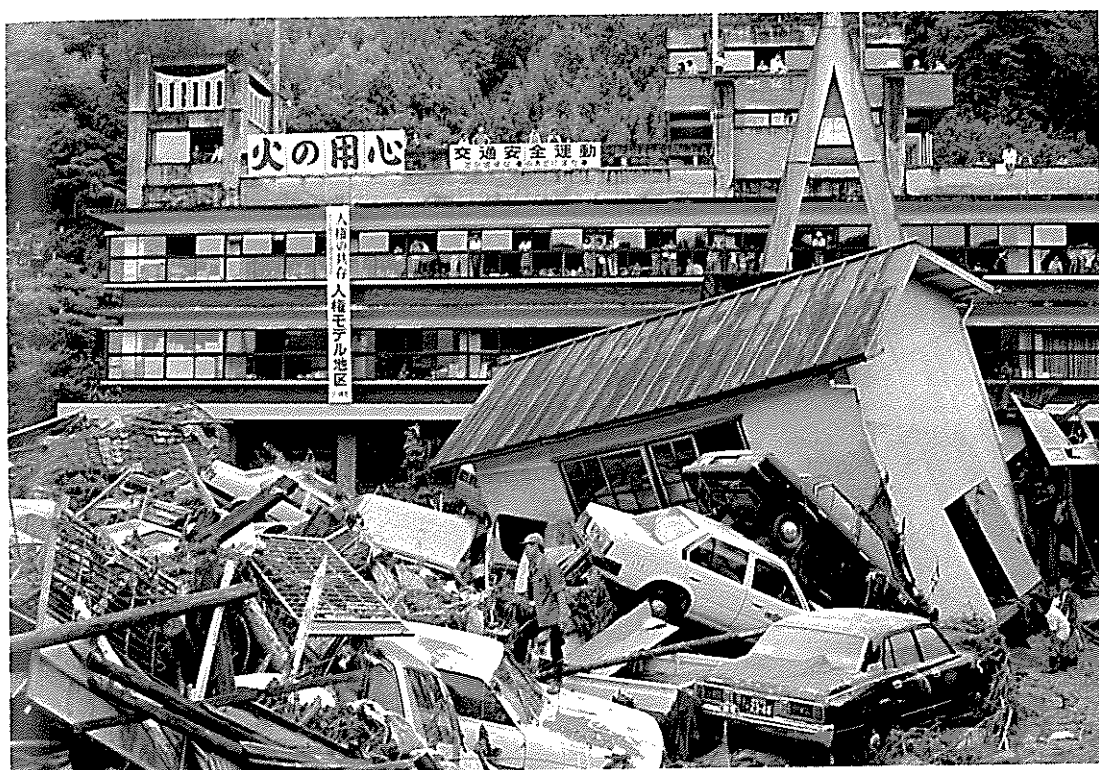
濁流の引いた後、役場前に二重三重に折り重なった車と流木（三隅町役場前）
