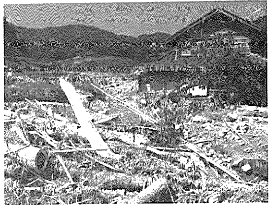
土石流により家屋の周囲は埋没
