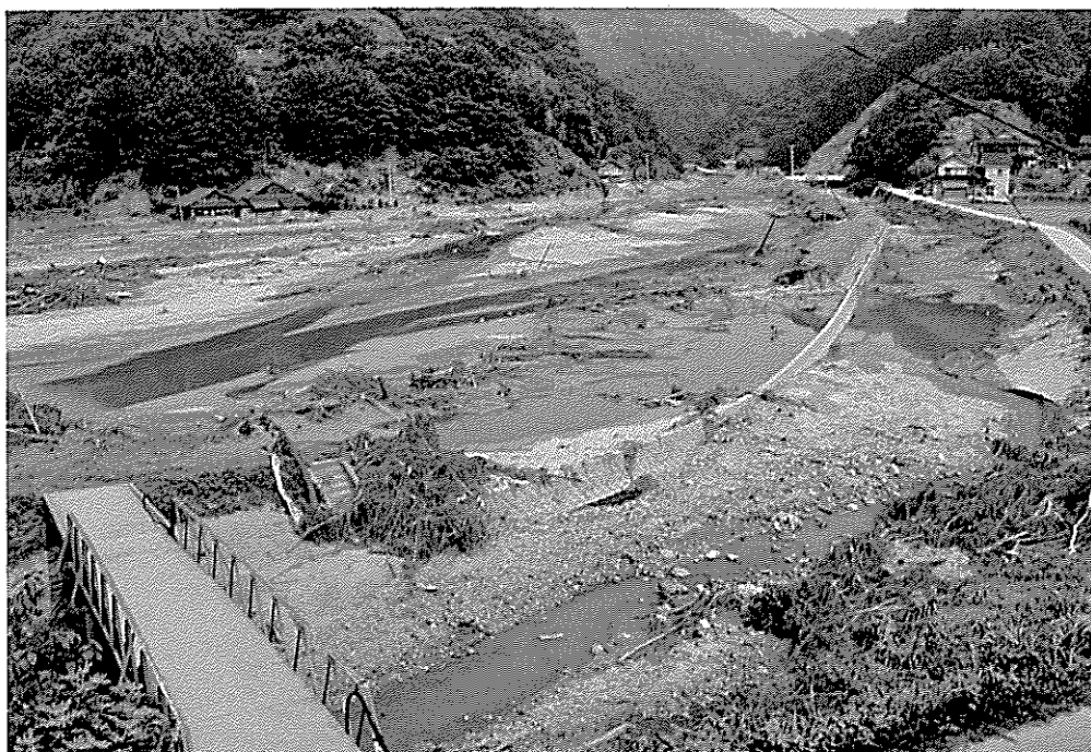
岡見川堤防の決壊により田や畑が一面河川と化した
