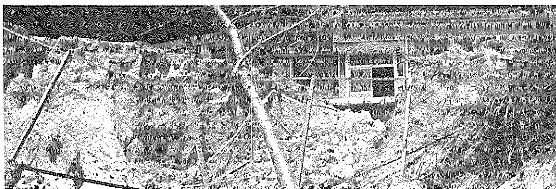
埋没、崩壊により校庭の三分の一が流失
