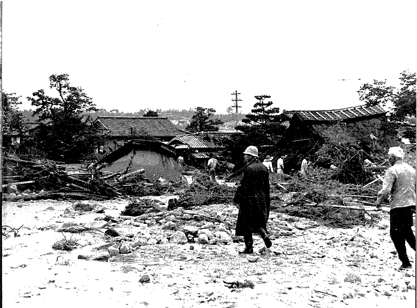
蟹満寺西側、天神川による被害
