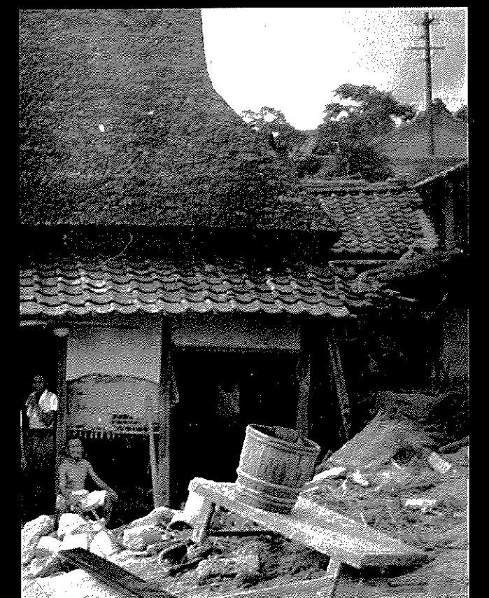
不動川決壊による惨状（平尾国鉄踏切付近）
