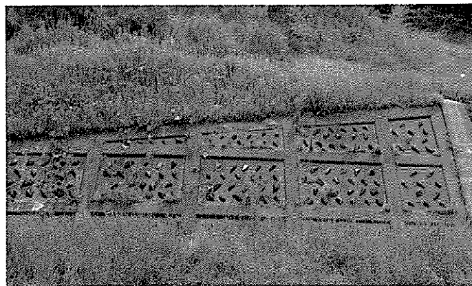
現在のコンクリート堤防（不動川）
