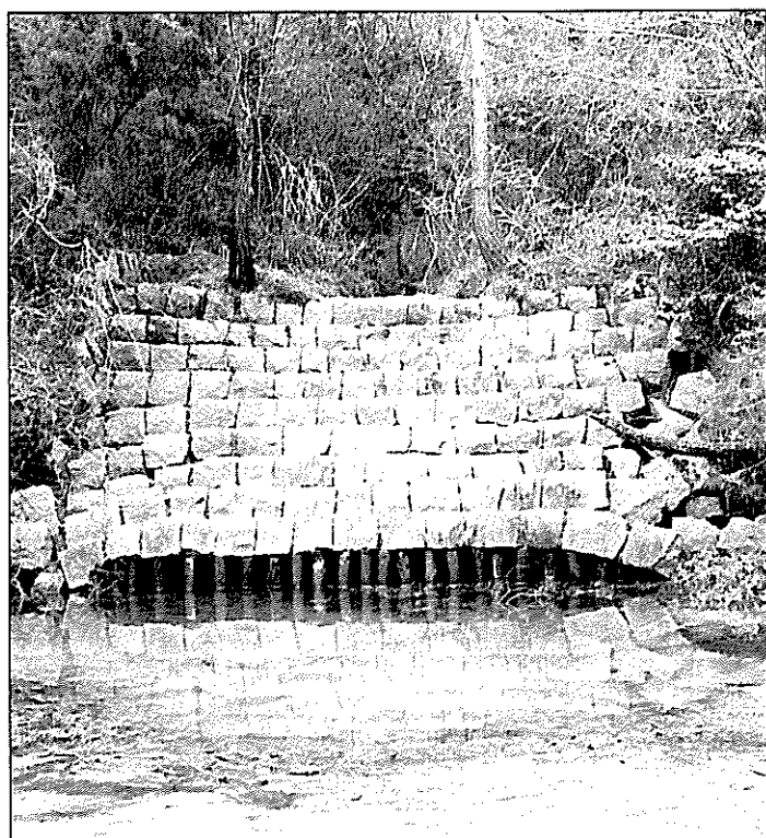
不動川上流相谷に残るデレーケえん堤。オランダの合理性と近代的土木技術の産物であるが、わが国古来からの工法を基礎としている。
