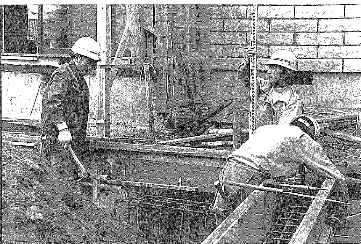
△町内の各所で基礎の打ち直し工事が
