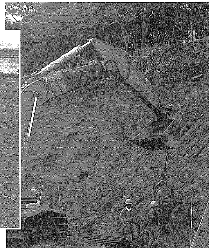
着々と進められる地滑り防止工事（芦崎）
