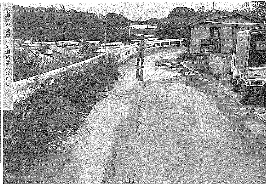
五明光橋の取付道路は一メートルも陥没
