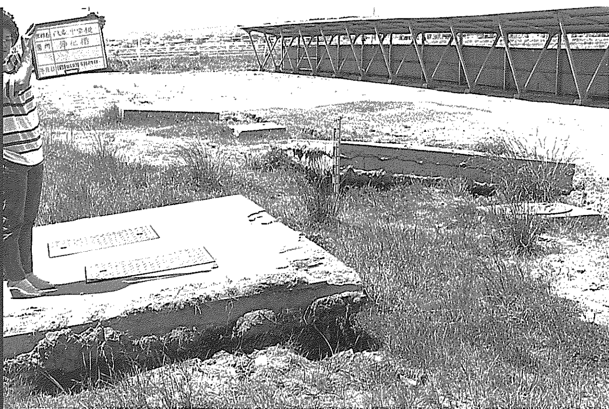
▷ 芦崎地区グラウンドにはいく筋もの亀裂が入った ◁ 湖小体育館のわきでは地盤が一メートルも沈下した
