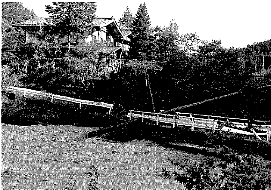
▲ 流木が欄干を直撃、橋の流失は免れたものの すぐ下流の民家が押し流された
