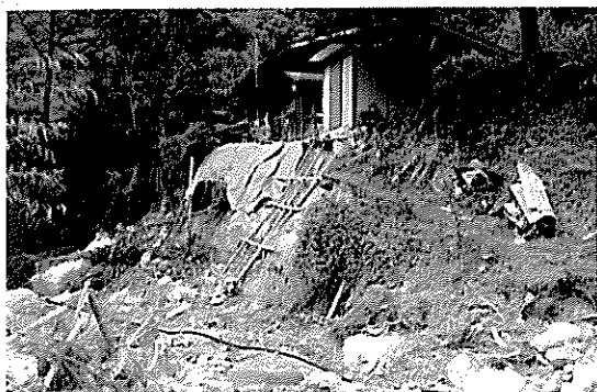
▲ 林道曾倉沢線入口にある勝山清吉 氏住宅はよもやと思われる位置だ ったが流失の危険にさらされた
