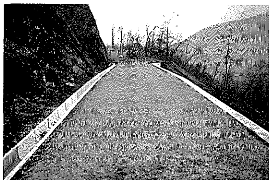
▼ 大変な難工事の末復旧なった曾倉沢林道
