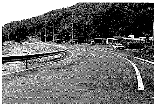
▲ 県道も民家も全て押し流された 大平地籍も全面復旧した
