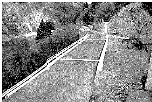
▲ 崩落がひどい為橋梁により復旧した 県道奈川木祖線 新湯道地籍
