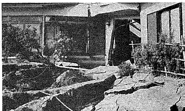
宅地の地割と埋没により全壊となった住宅(本内)
