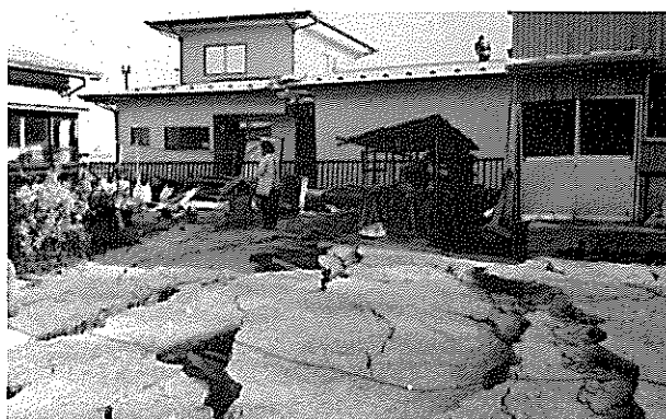
流砂現象により地割した宅地
