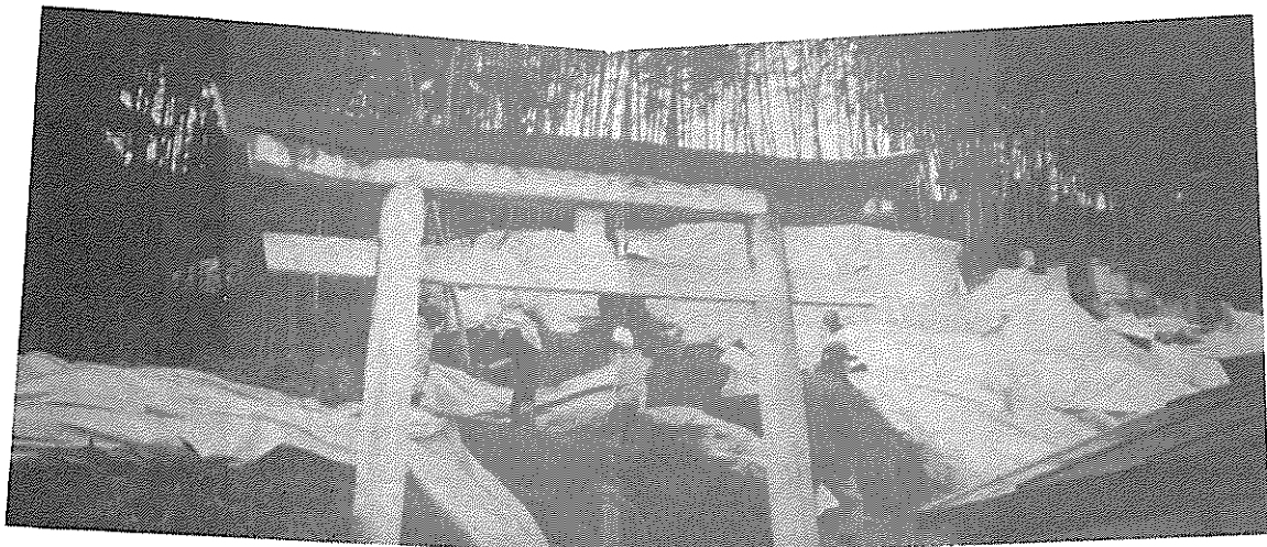
写真-12 旭町地区，斜面の変状
