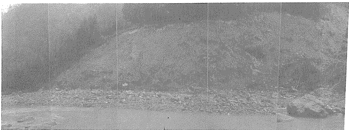
写真-27 桑原地区，斜面末端の洗掘状況
