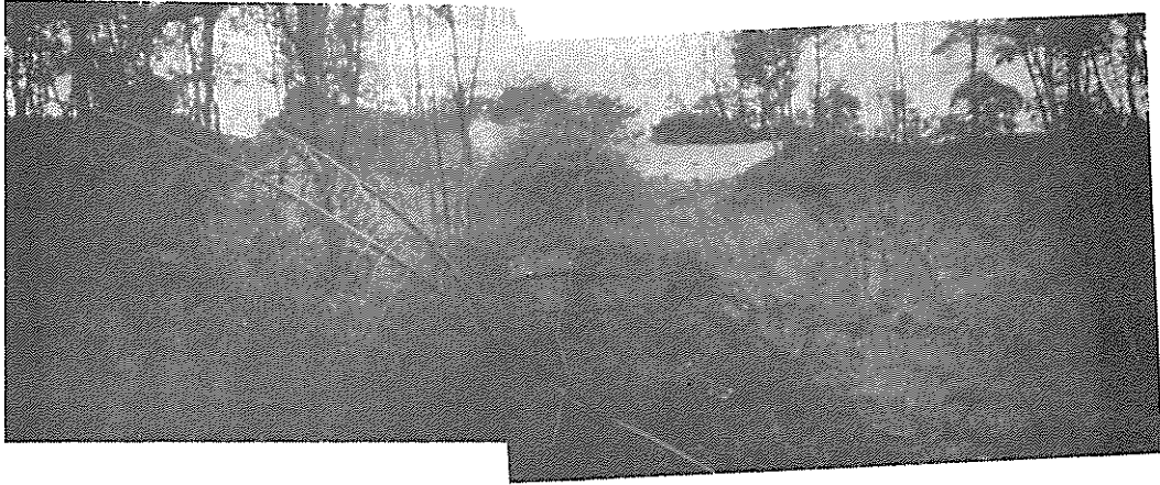
写真-6 桜ヶ丘地区，1地区の状況
