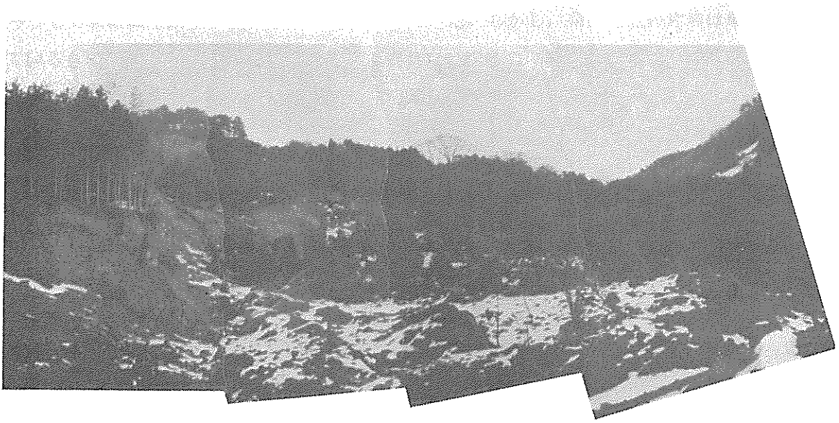
写真-26 桑原地区全景
