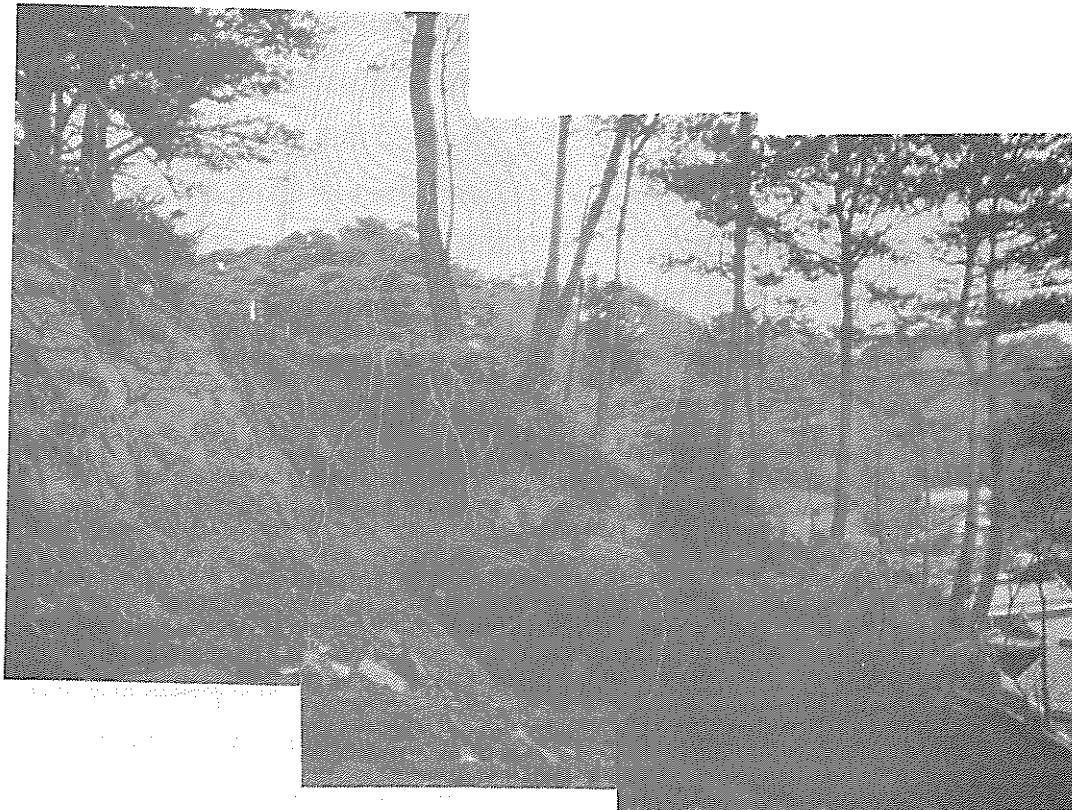
写真-22 中組地区，A2ブロックの滑落崖
