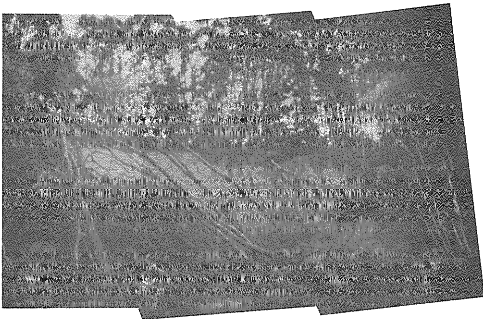
写真-7 桜ヶ丘地区，2地区の状況
