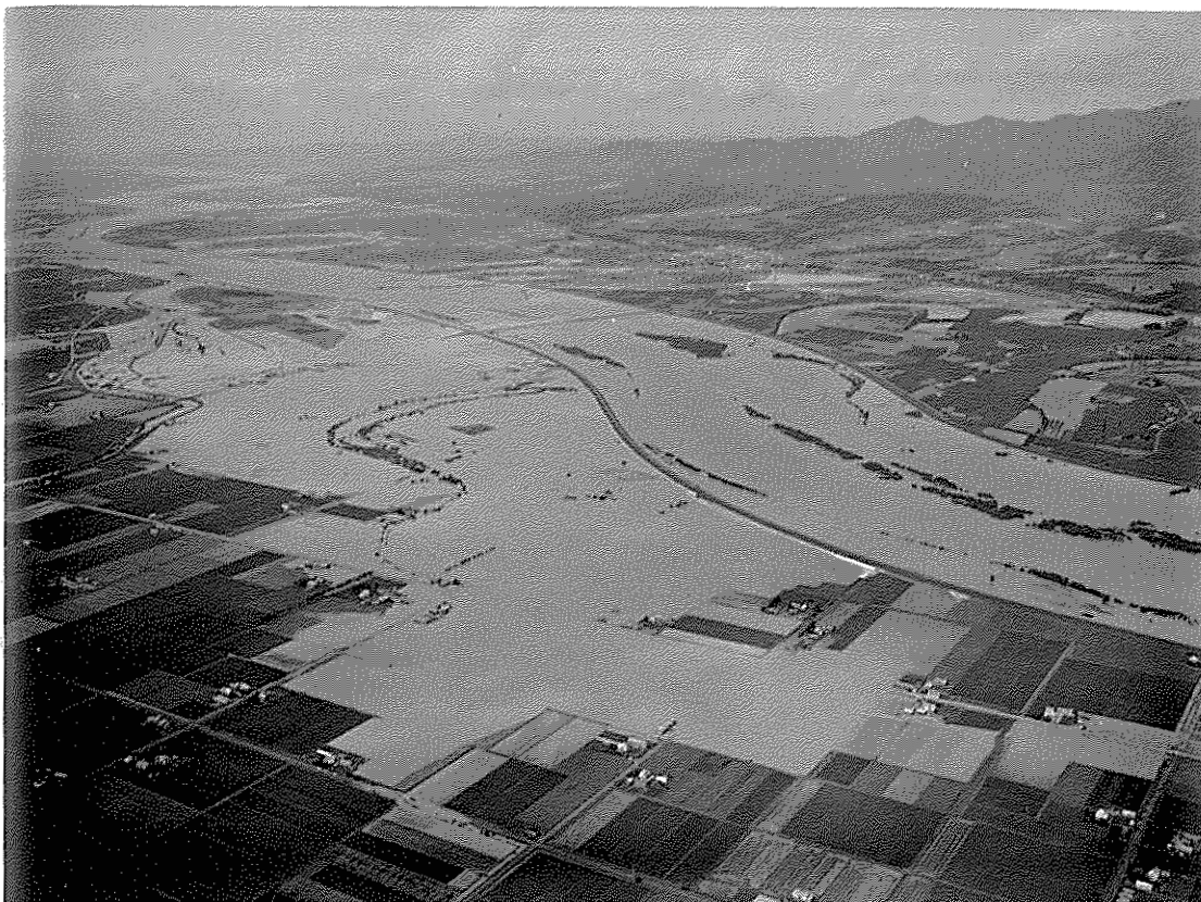
▲ S 56.8.6 午前11時ごろ奈井江大橋附近の浸水状況
