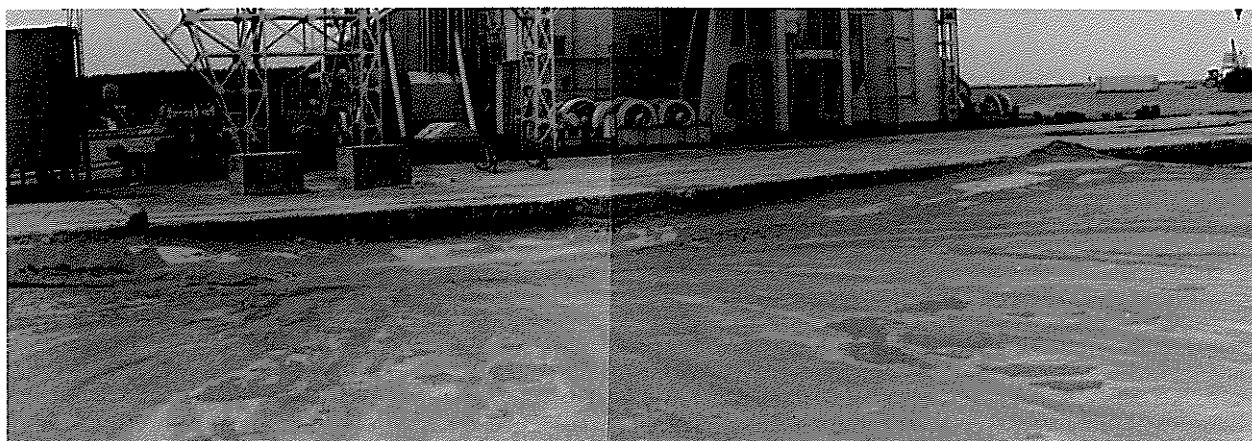
写 6-16 能代港中島 1・2 号岸壁の被害
