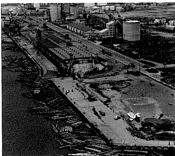
写 8-6 秋田港、木材の流出状況
