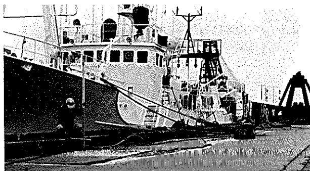
写6-11 船川港-4m物揚場の被害
