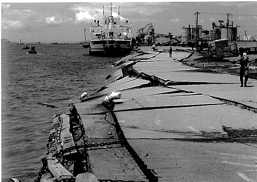
秋田港本港地区、-4.0 m 物揚場
