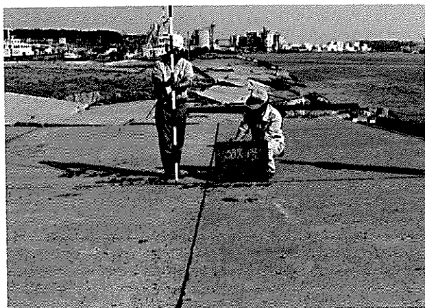
写 6-5 秋田港下浜-4 m 物揚場
