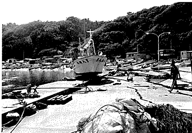
写6-23 戸賀港-3m物揚場の被害
