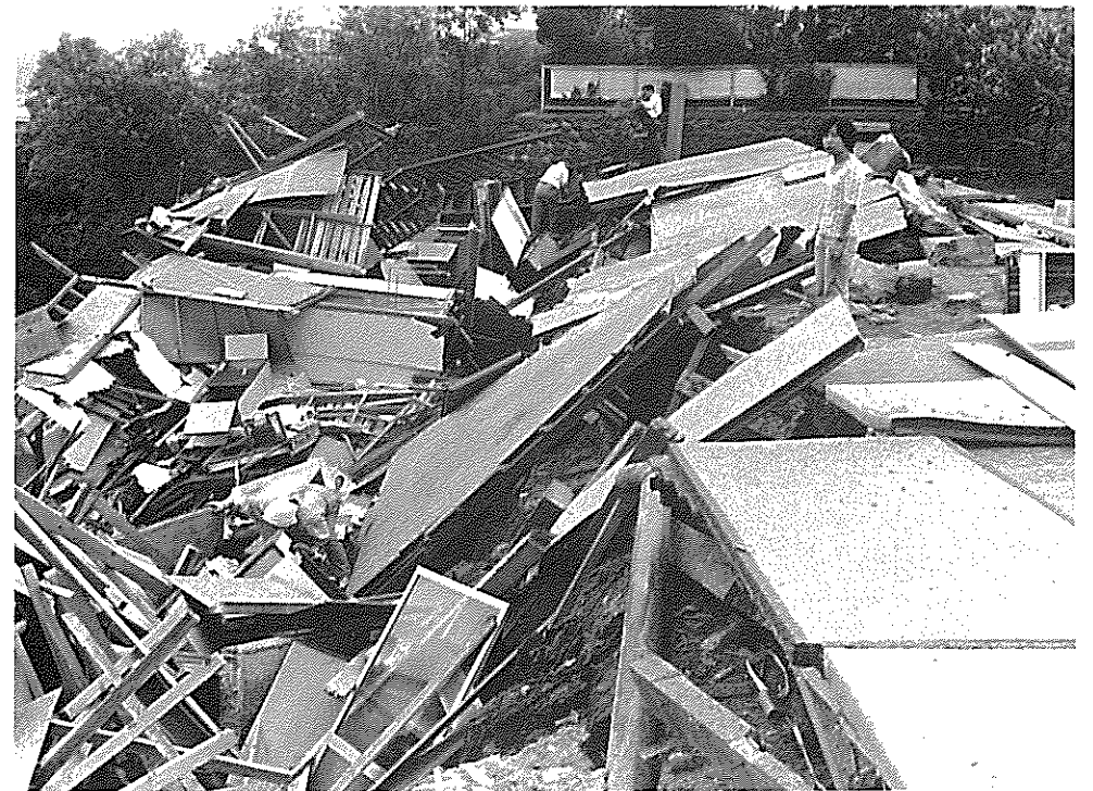
アパート倒壊（市北部・一念防）
