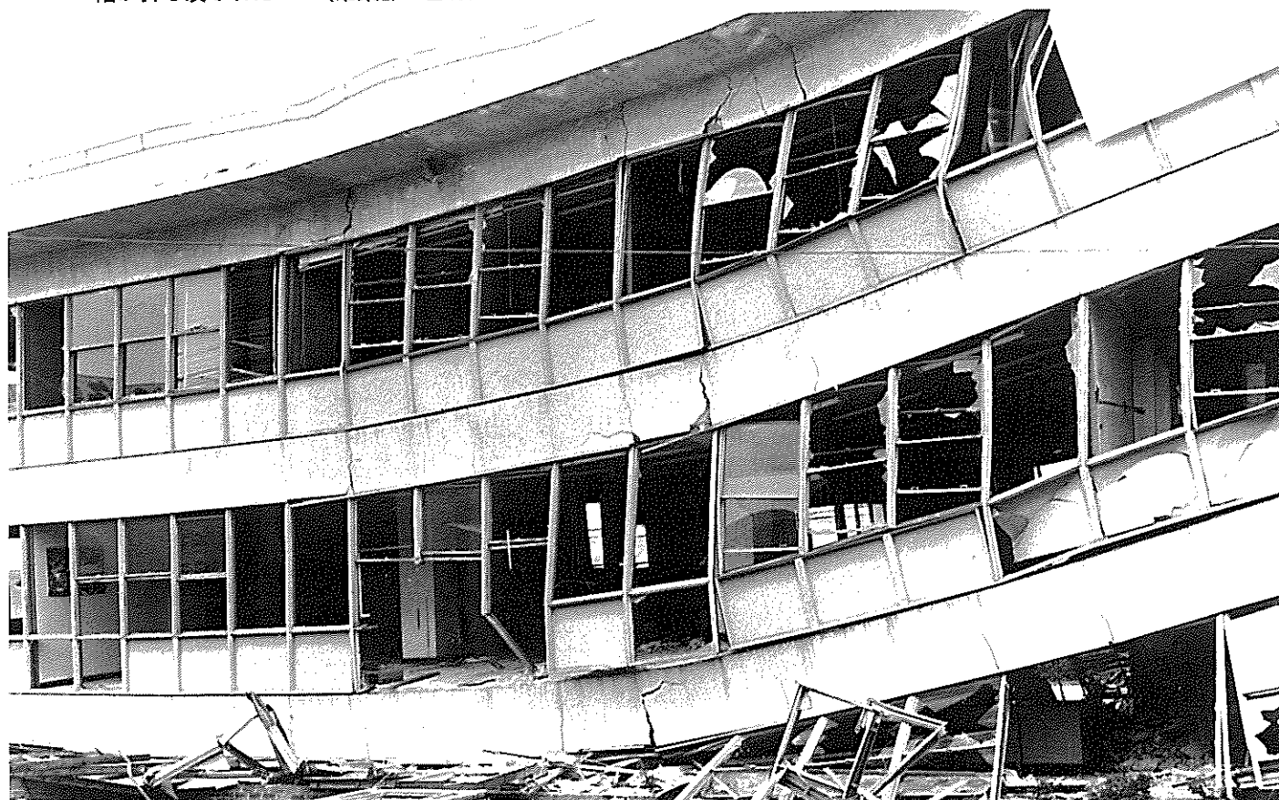
一階が押し潰されたビル（市東部・苫竹）
