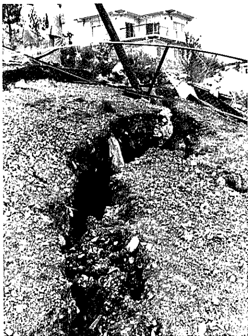
市内各所に地割れ（市南西部・緑ヶ丘）
