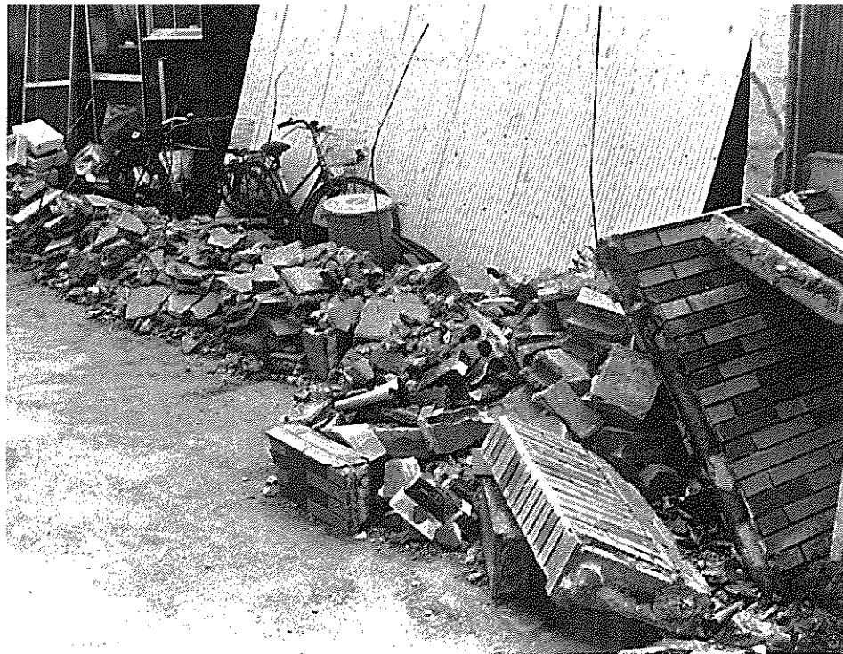
倒壊したブロックべい (市内各所)
