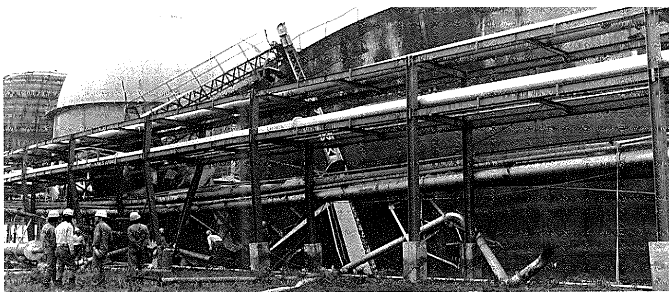
崩壊炎上した市ガス局ホルダー（市東部・原町）
