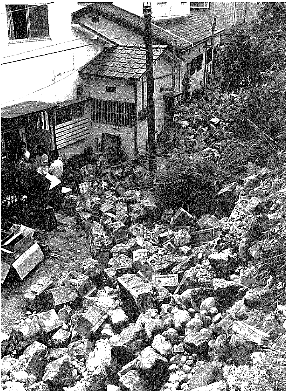
崩れた石垣（市北東部・高松）
