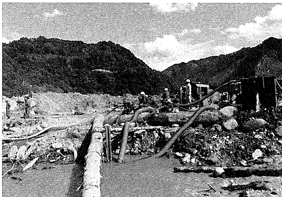
ジェットポンプによる土砂除去作業
