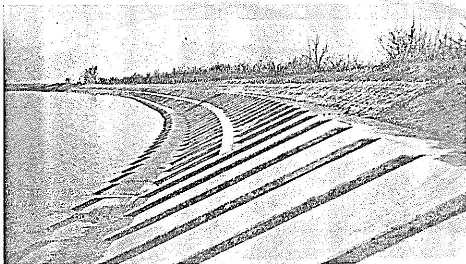
◀溝延第4護岸災害 復旧工事
