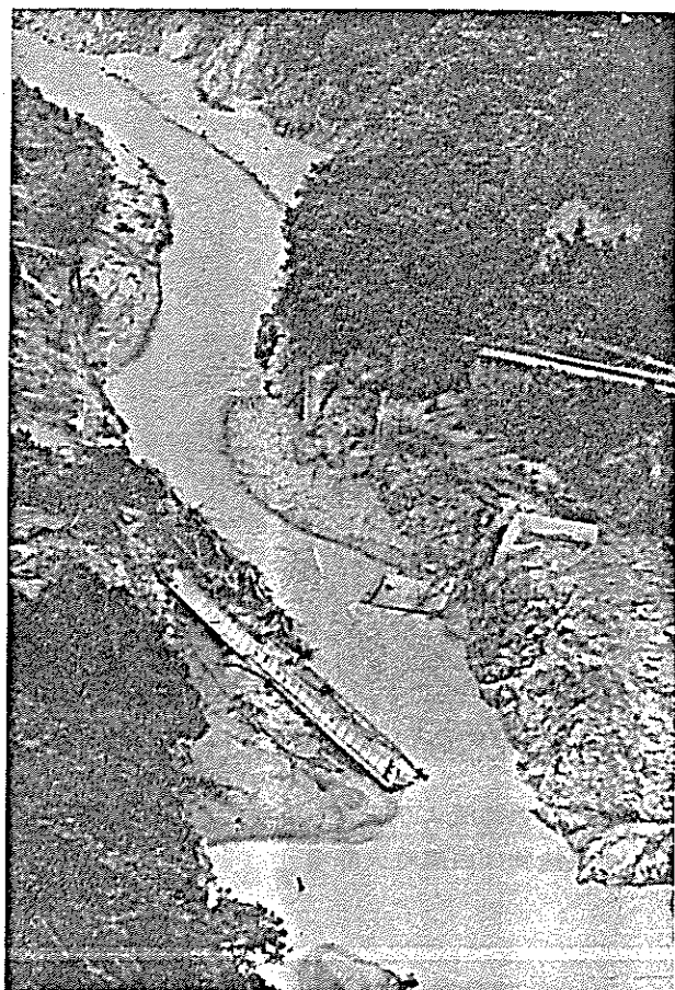
激流におし流された国道▶ 113号線の中ノ橋と国鉄米坂 線、荒川第3鉄橋の残がい
