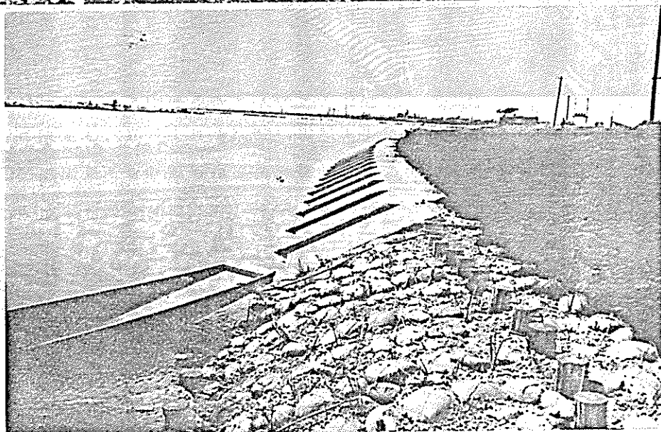
下野第1護岸災害▶ 復旧工事
