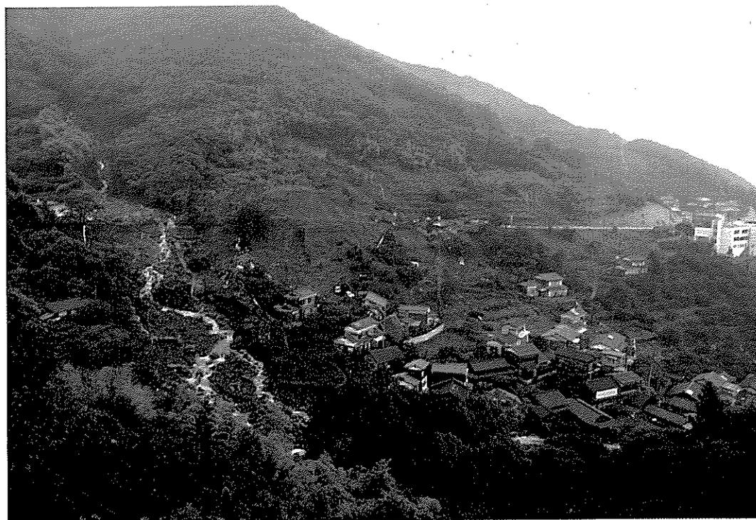
土石流流下状況と地すべり性崩壊
