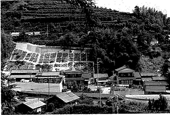
左斜面は対策工事による効果。右斜面は未対策のため崩壊。
