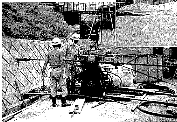
湯谷団地ですすめられた集水横ボーリング
