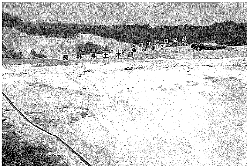
整地の完了した地すべり地
