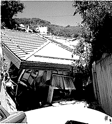
道路上に押し出された家屋
