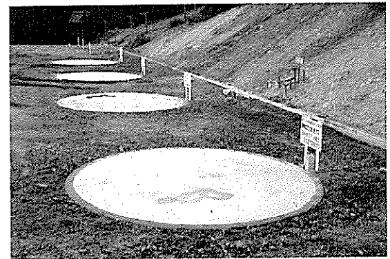
▲完成した深礎工(φ5,100)
