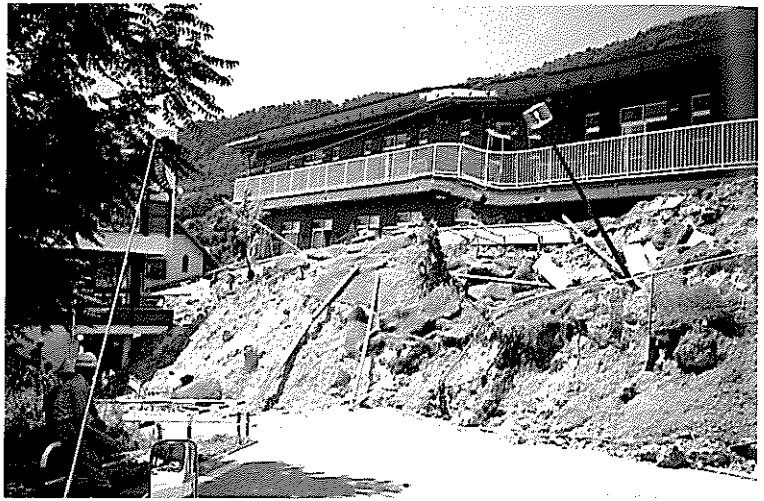
道路と望岳台団地へ押しよせた土砂と老人ホーム
