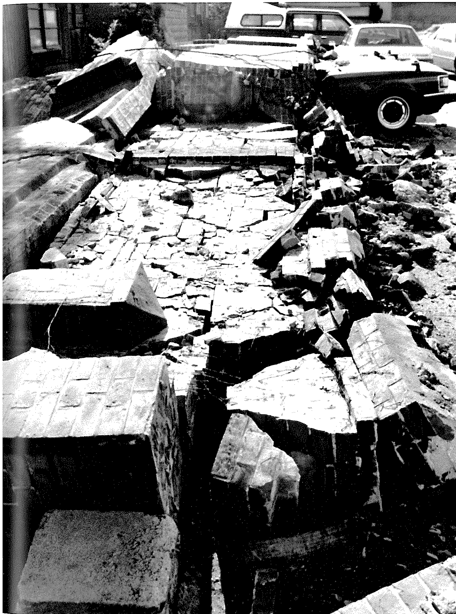
レンガ塀の倒壊 (秋田市)
