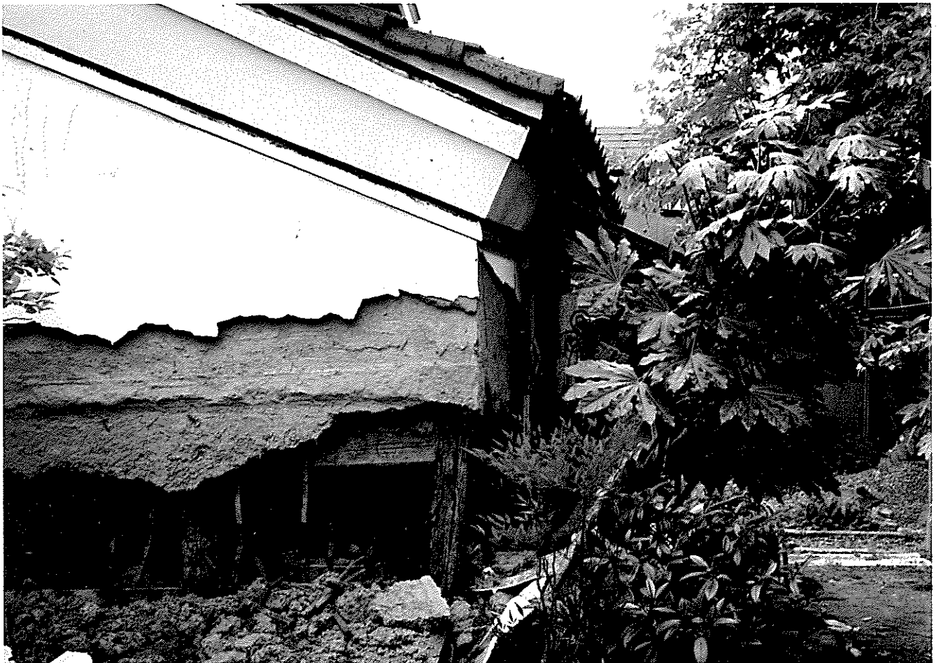
家 屋 の 損 壊 (能 代 市)
