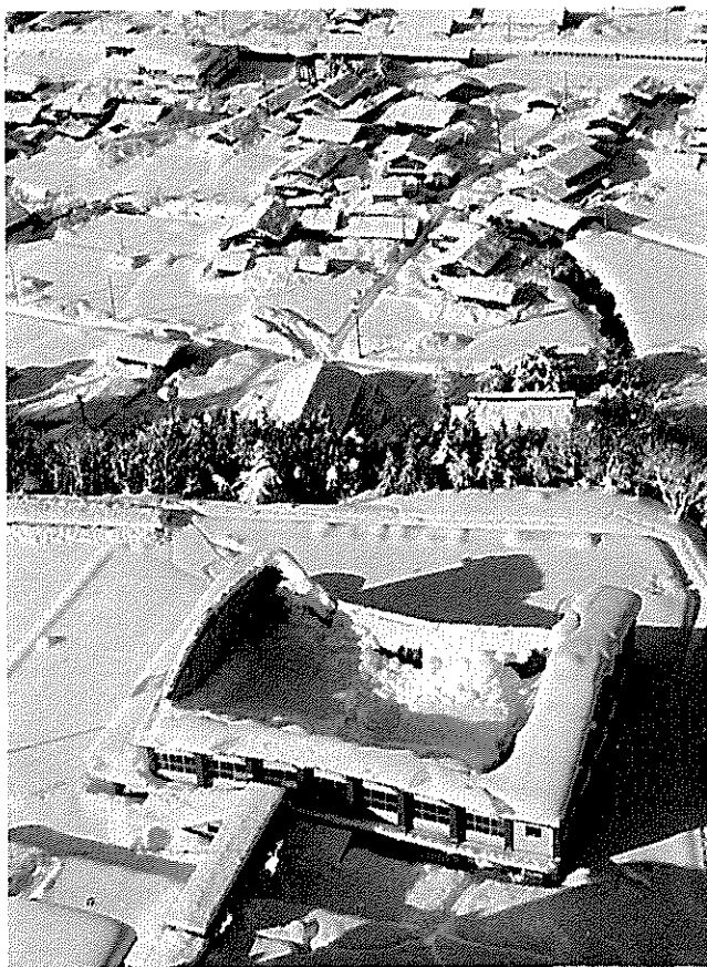
押しつぶされた屋内体育館 (白鳥町) (中日新聞本社提供)
