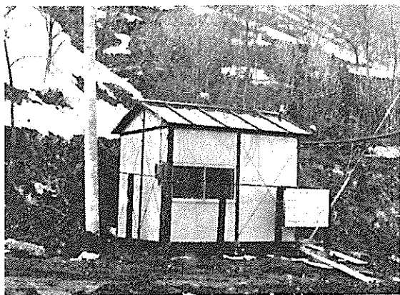
写-10.1.3 観測ステーションの設置状況(西山川地域)
