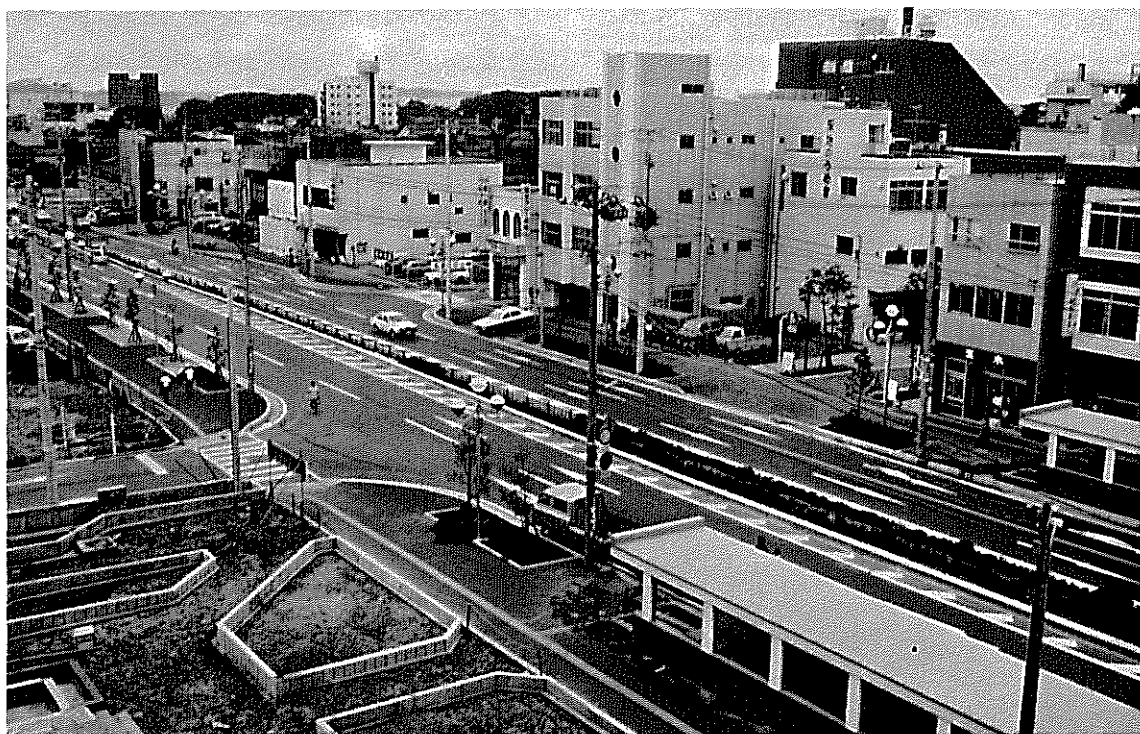
四車線（巾員32M）で完成した大通り、右下は地下歩道入口
