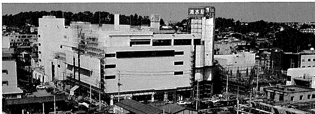
突貫工事中の再開発ビル
