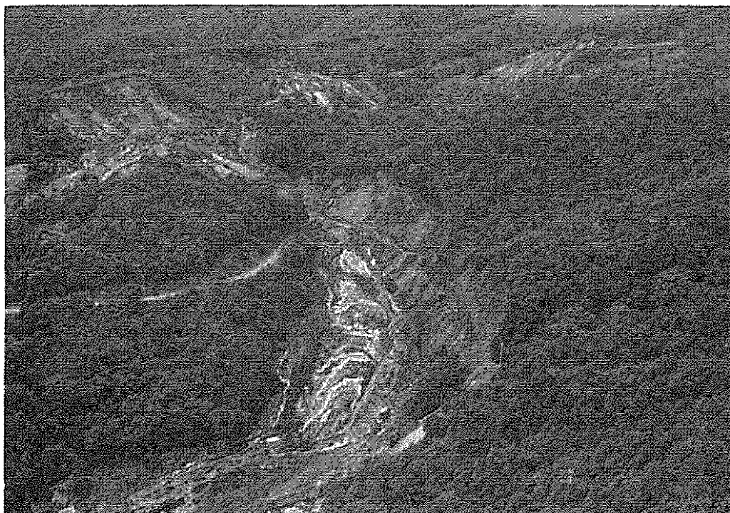
写真 3.9 斜面崩壊による道路流失（御岳高原への有料村道，十二権現付近）
