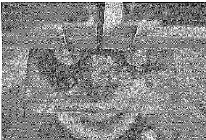
写真 3.28 松原橋の支承浮上り防止装置 の回転（橋脚上）
