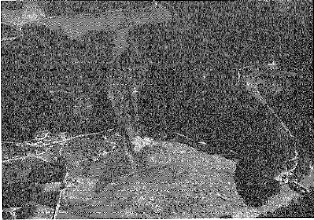
写真 3.11 斜面崩壊による道路流失（滝越地区の林道）
