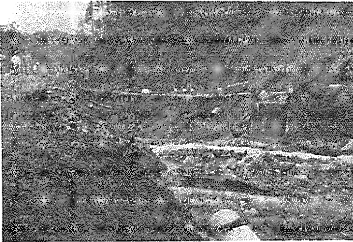
写真 3.44 土石流による桁の流失（鈴ヶ沢橋）
