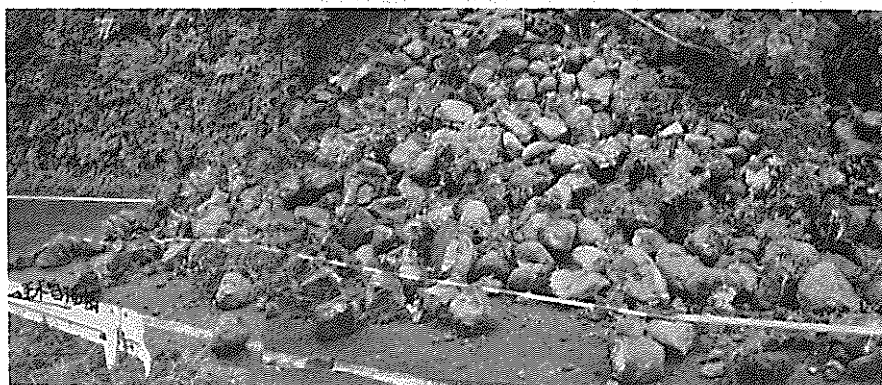
(c) 最大余震後の状況
