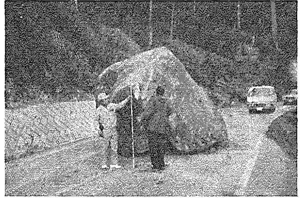
写真 3.2 道路への落石（約 3 m×3 m, 王滝村道）
