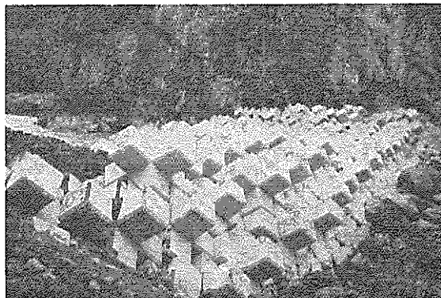
写真 3.56 施工直後の床止ブロック
