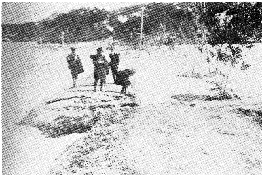
▲ 断層のため大きくずれた道路（網野町郷）
