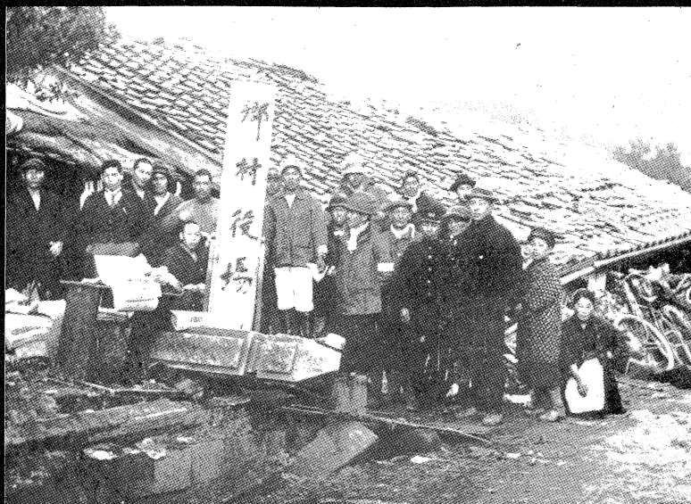
▲ 倒壊し、屋根だけとなった元郷村役場（網野町）
