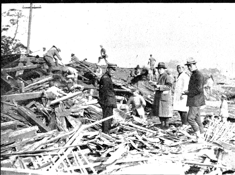
▲ 全壊した網野町小学校の跡片づけ
