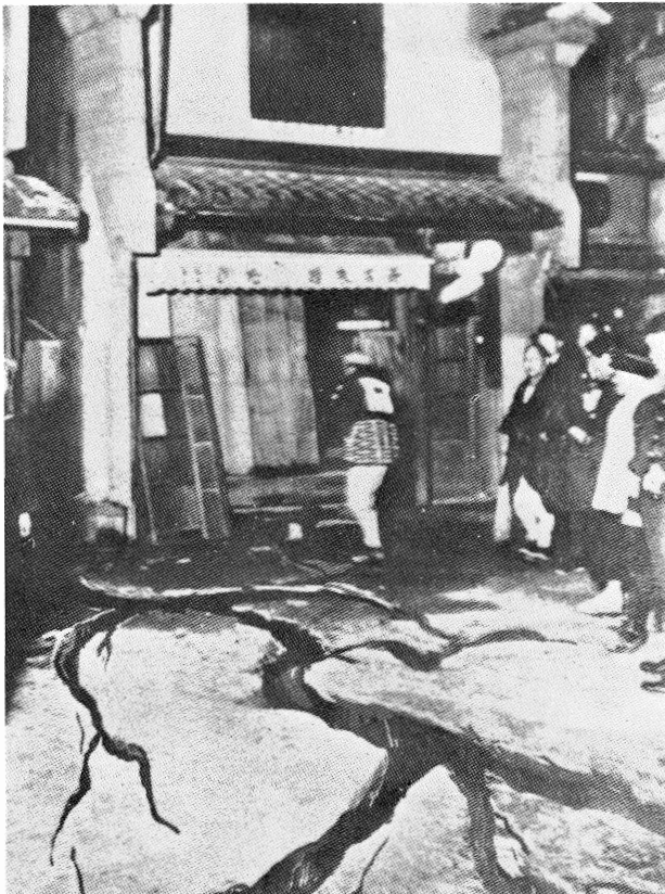
▼ 軒先まで亀裂した道路（加悦町）
