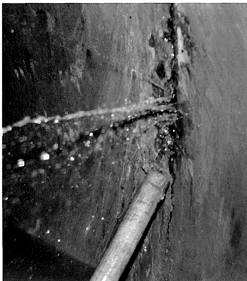
同 上 (仙台市公共下水道七北田川右岸幹線)
