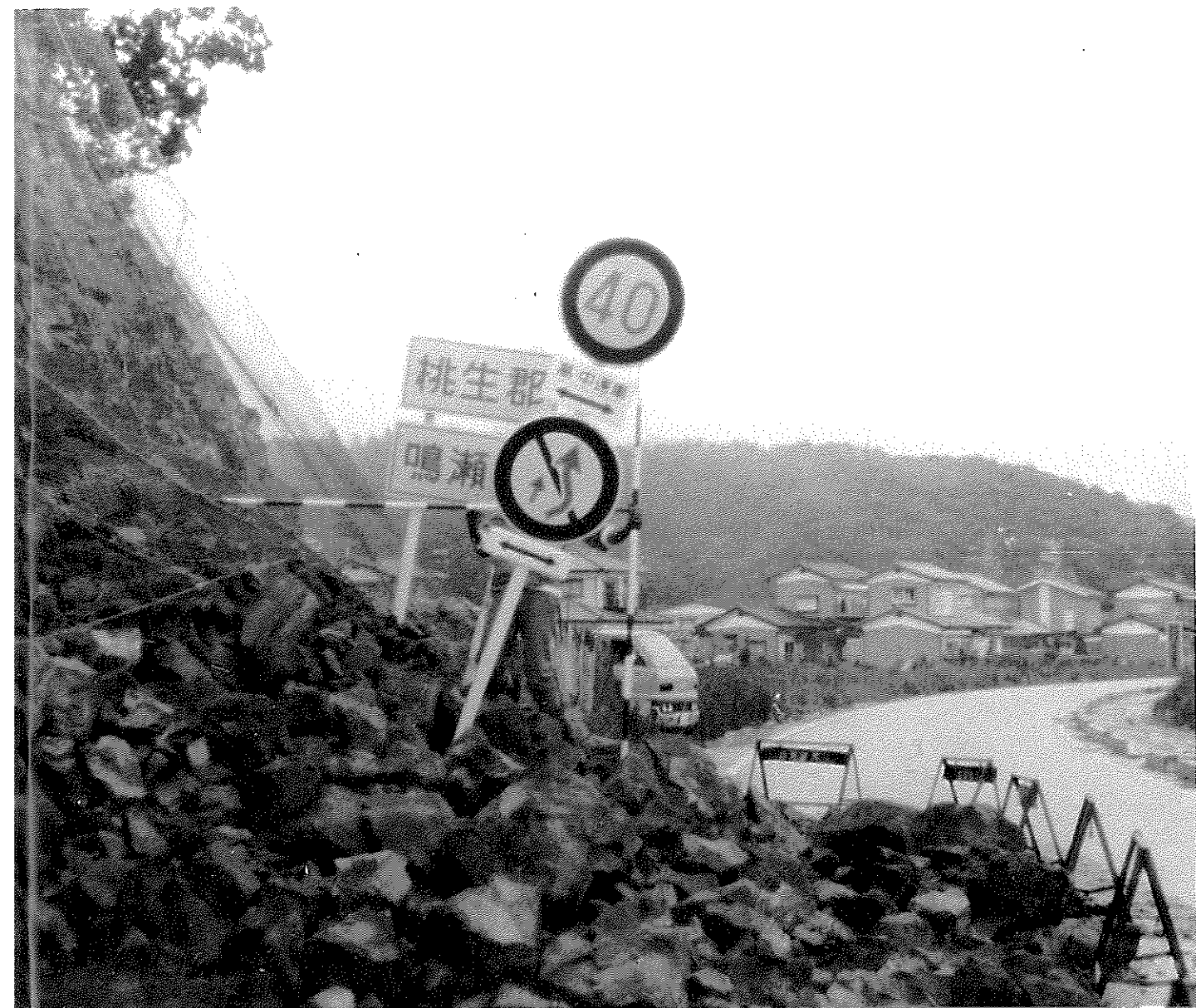
落石と崩土による通行止。国道286号（仙台市羽黒堂）
