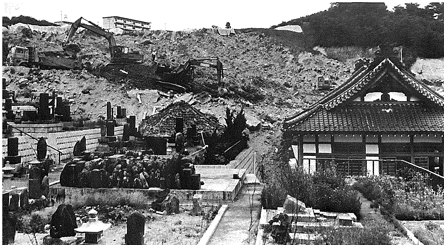
白石市寿山の緑ヶ丘団地では砂質シルトの高さ30mの盛土が震動により崩壊した。 崩壊面積は約16,000㎡、崩壊土量は130,000㎡に及んだ。(白石市寿山・緑ヶ丘団地)
