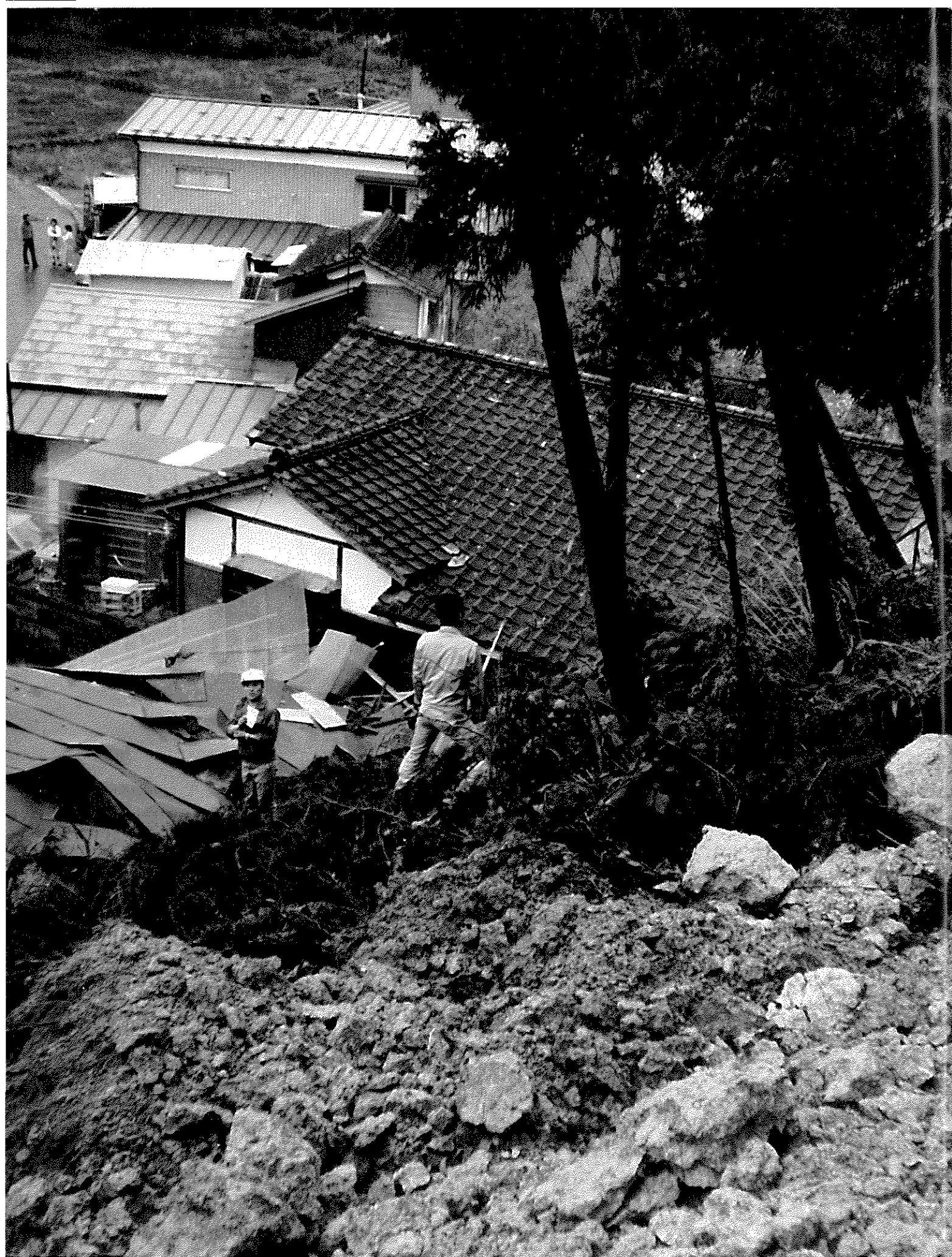
松島町の崖崩れ。6000㎡の土砂が崩壊し住宅4戸が被災重傷者1名が出た
