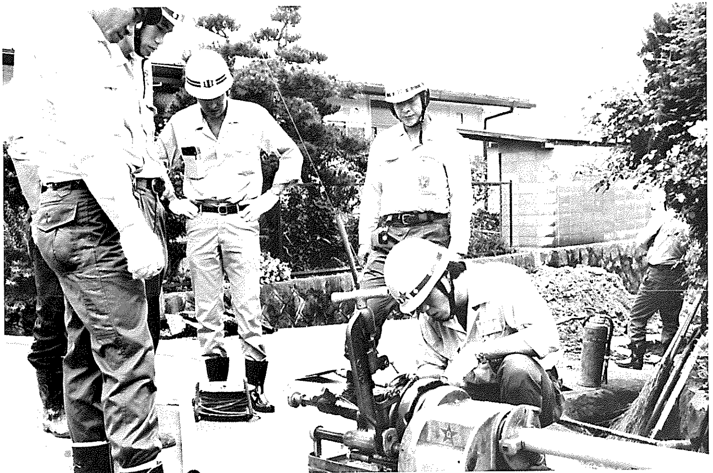
ガス復旧だけで作業員の動員数は延26,000人を記録した。
