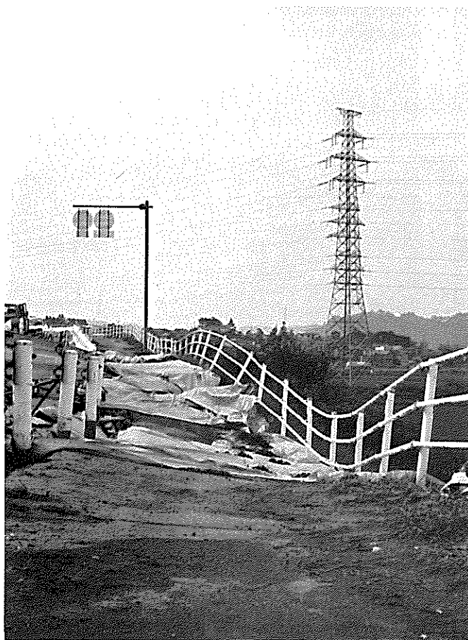
国道4号(仙台バイパス)の路肩部陥没状況（仙台市小鶴） 路側歩道階段の破壊。一般県道・荒浜原町線（仙台市宮城野原）
