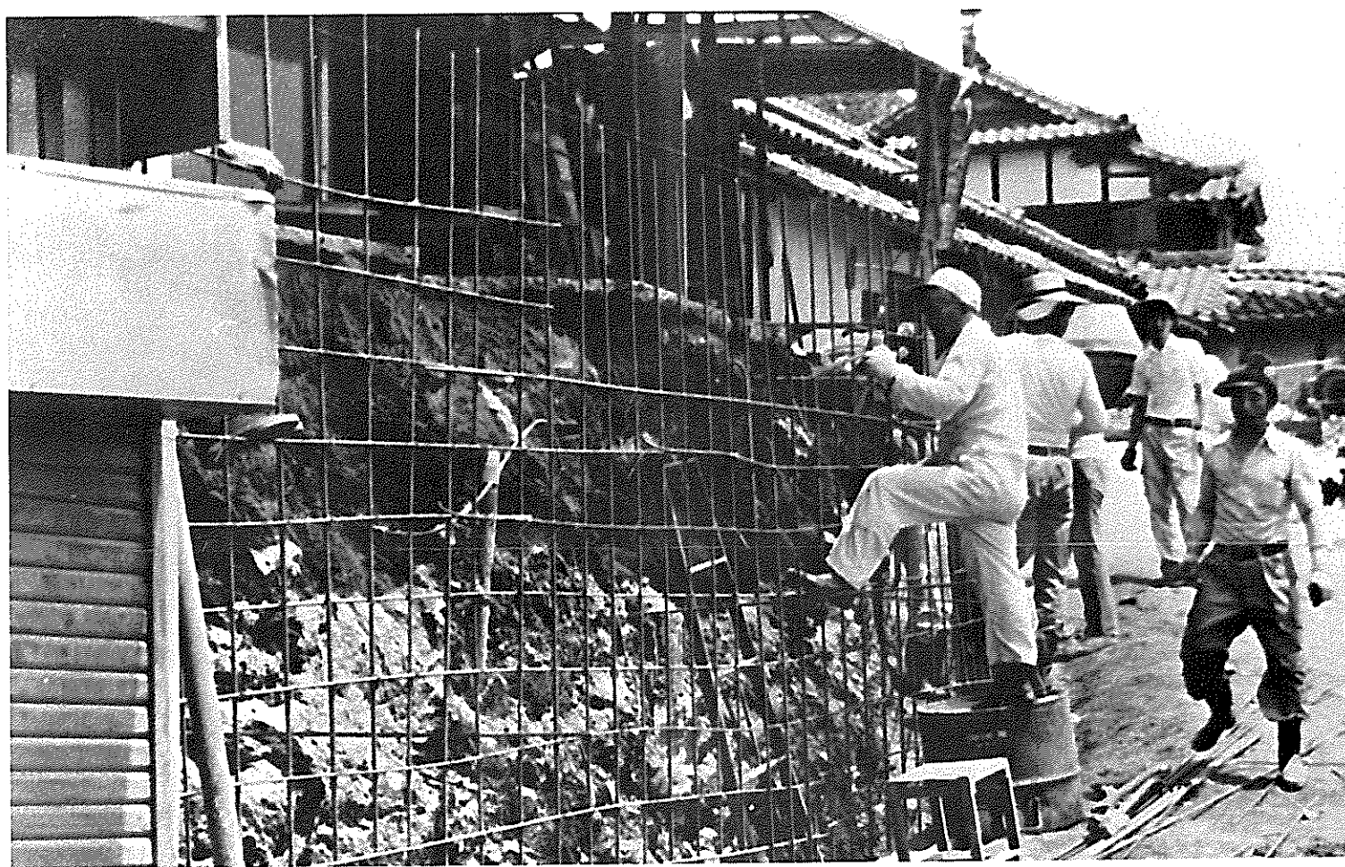
崩れた石垣の復旧
