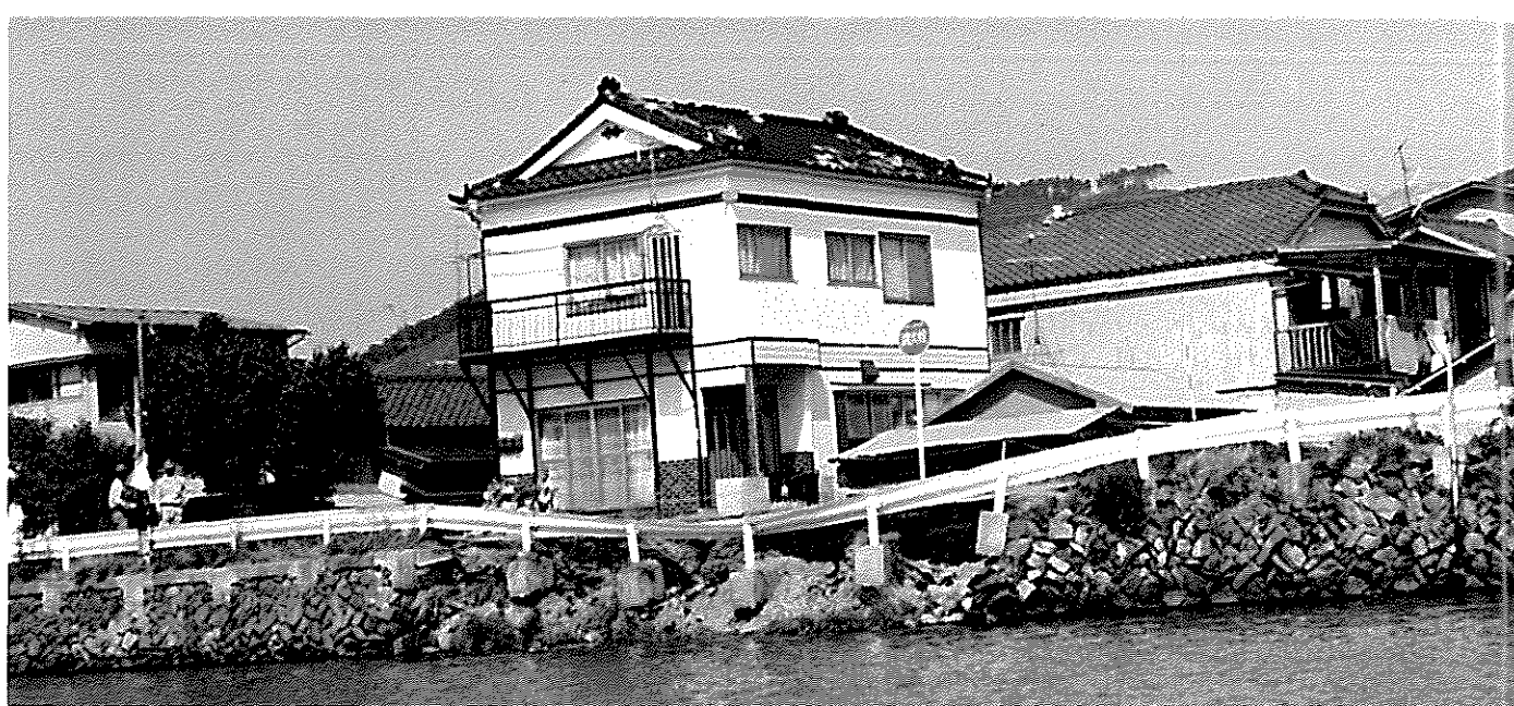
石積護岸のすべりによる破壊 (旧北上川左岸・不動沢護岸)
