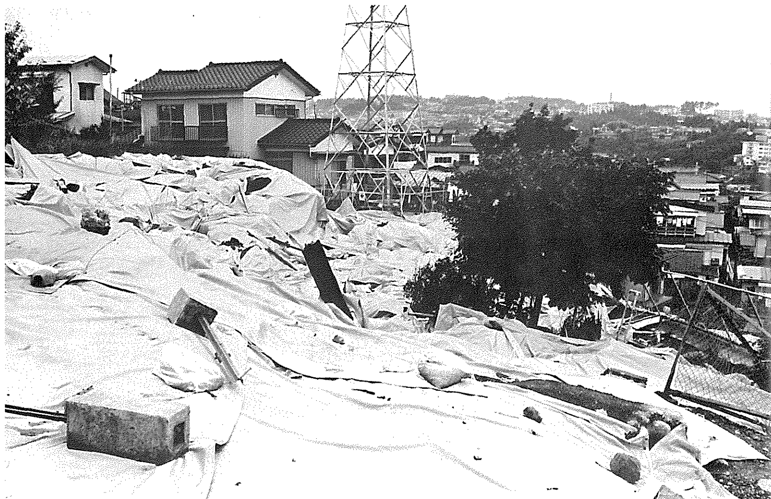
谷止工左岸隣接部は盛土厚が約14mもある宅地で、且つ近辺の地下水が集っているため、面積約10,000㎡にわたって崩壊を起した。(仙台市緑ヶ丘三丁目畑崎沢地内)
