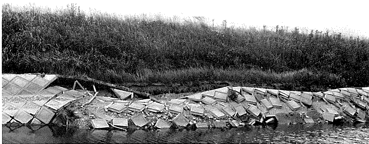
平張ブロック護岸の崩壊（定川右岸・矢本町上区）
