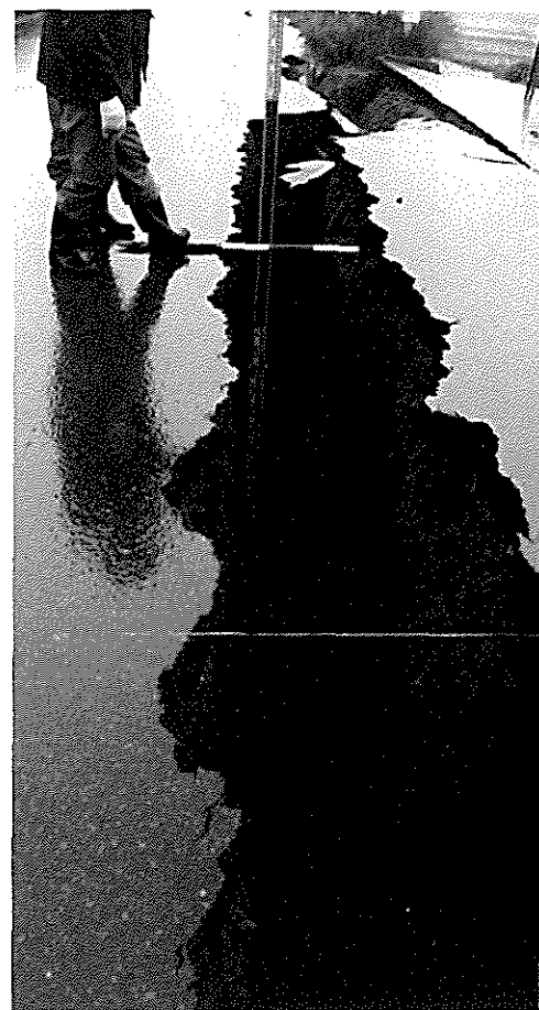
人間が楽に入るほどの大きな亀裂 （北上川左岸・橋浦堤防）
