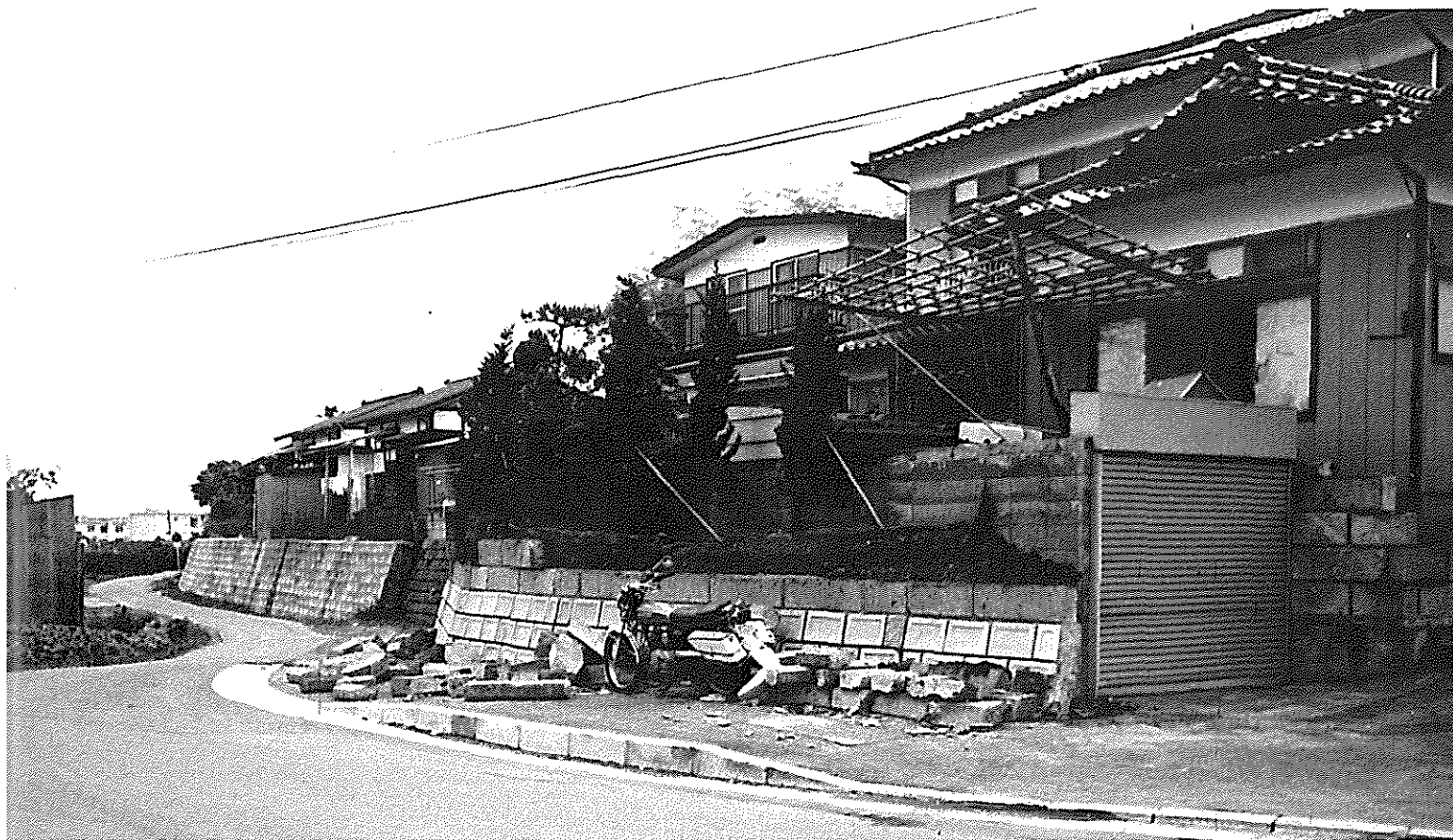
耐震性の弱いコンクリート並びに石製ブロック塀の補強が痛感される。
