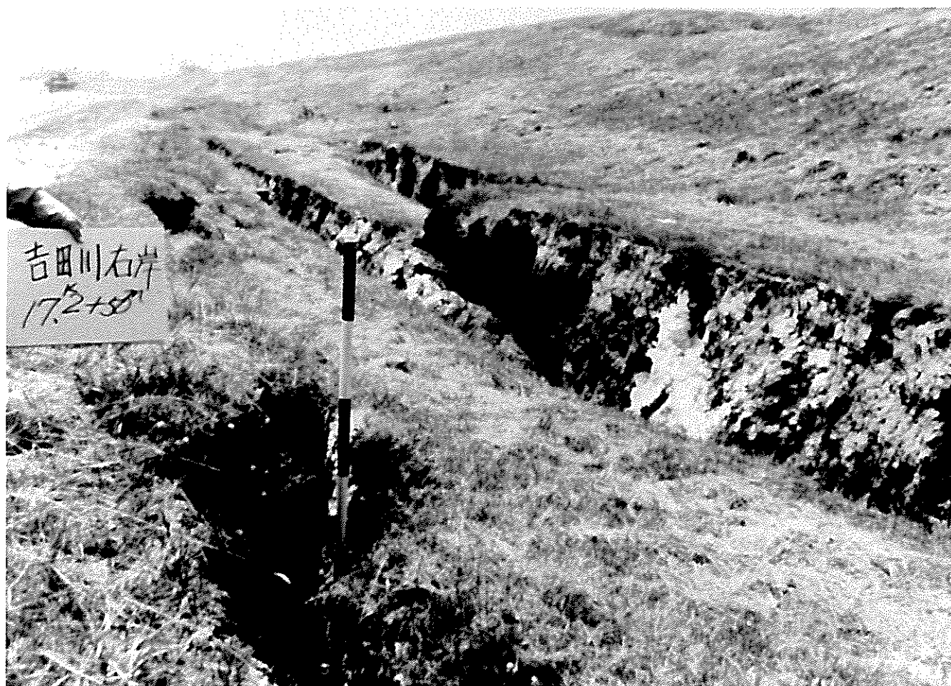
幅1 m、深さ2 m程度の亀裂が幾重にも走っている。(吉田川右岸・山崎堤防)
