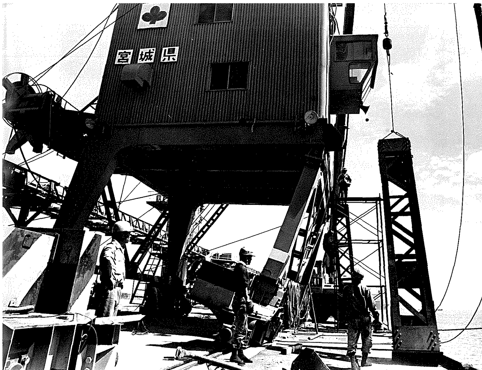
荷役機械が脱輪し、脚部が曲り海側に傾斜した。(重要港湾・石巻港)
