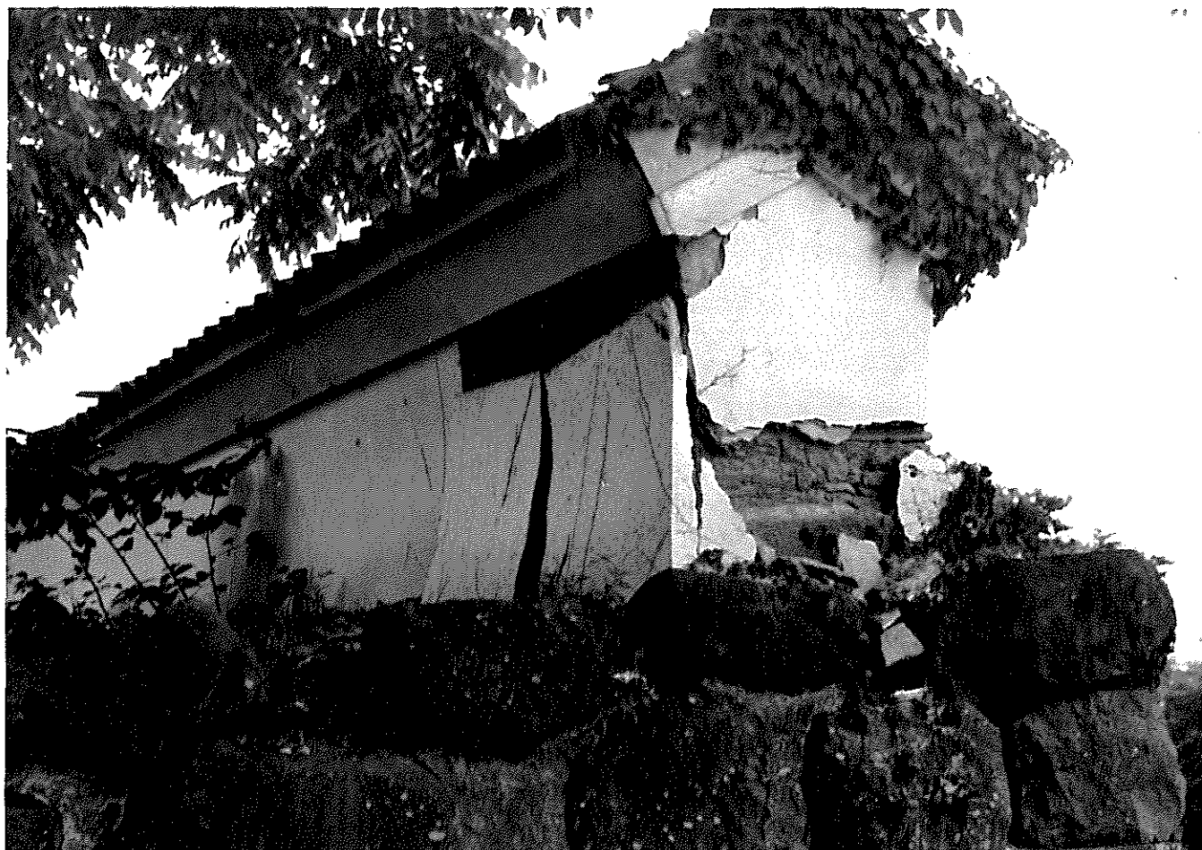
青葉城多聞堀の損壊（仙台市・青葉山公園）
