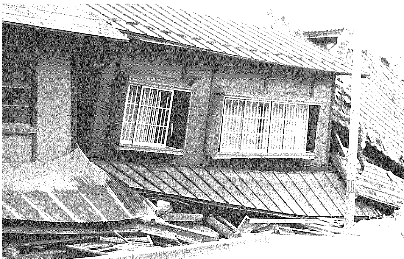
軟弱地盤が倒壊を助長した。(米山町)
