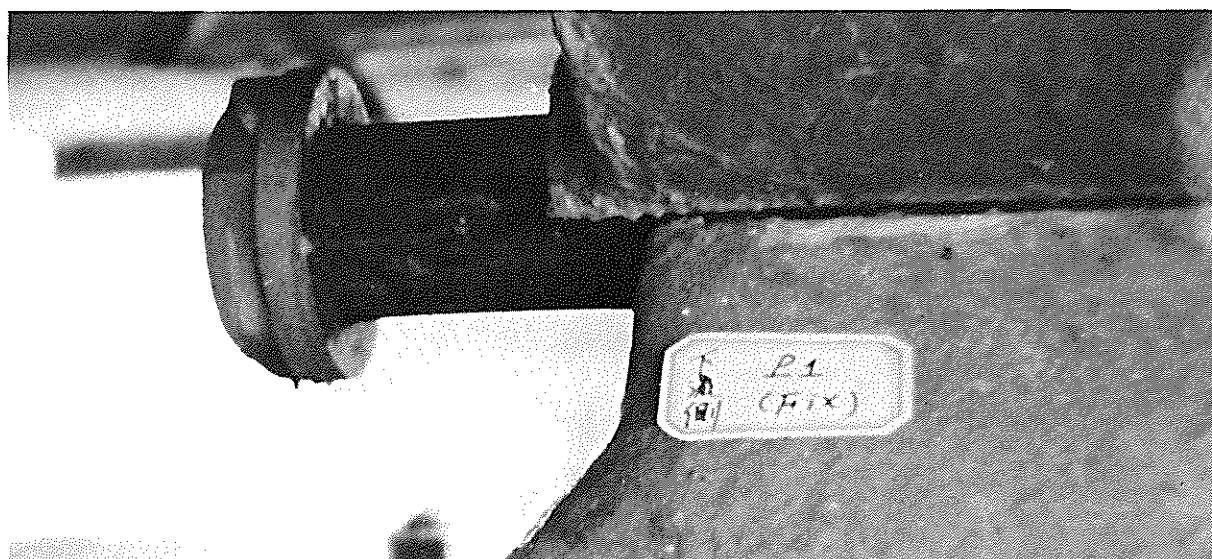
米谷大橋。P1固定沓のズレ及びセンターピンの抜け出し。ナット部は破断した。
