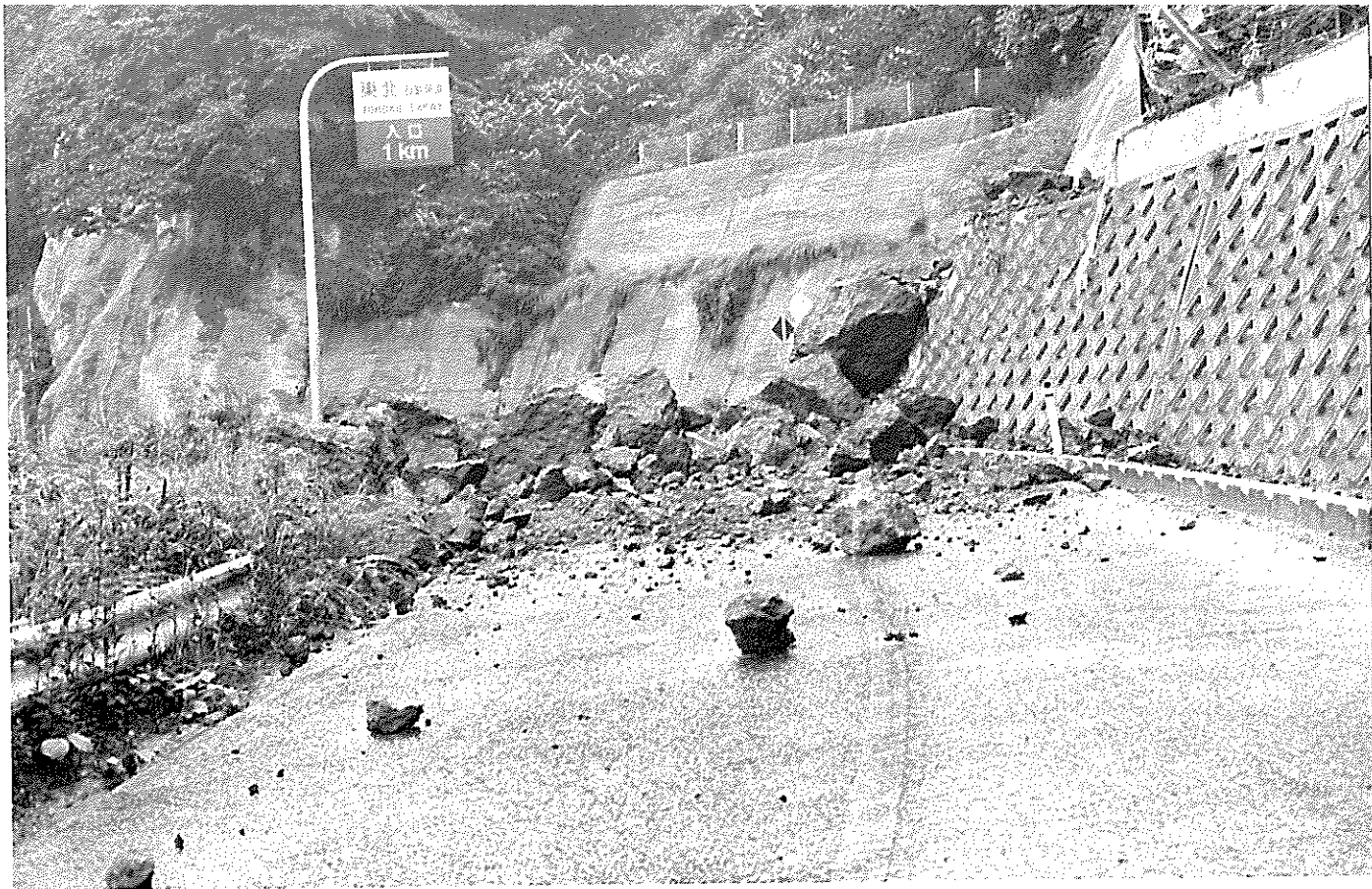
落石と崩土による通行止。国道286号（仙台市羽黒堂）
