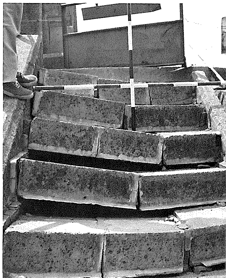
国道4号(仙台バイパス)の路肩部陥没状況（仙台市小鶴） 路側歩道階段の破壊。一般県道・荒浜原町線（仙台市宮城野原）
