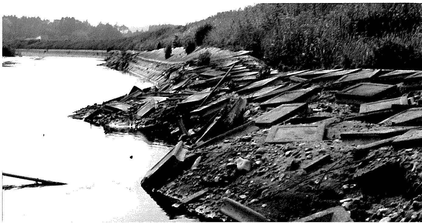
平張ブロック護岸の崩壊（定川右岸・矢本町上区）
