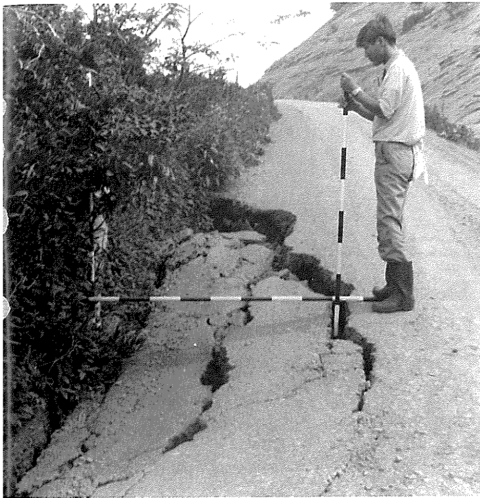
道路の亀裂・沈下が断続し、この区間で実延長653 m が被災した。 一般県道・大郷利府線（利府町森郷）
