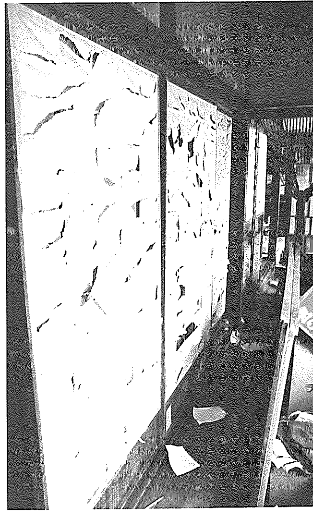
破損を免れた住家も内部の被害は大きかった。 (古川市)
