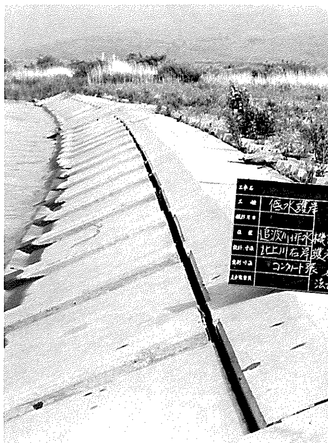
コンクリート格子張護岸の格子とスラブが 裂けている。(北上川右岸・辻堂護岸)
