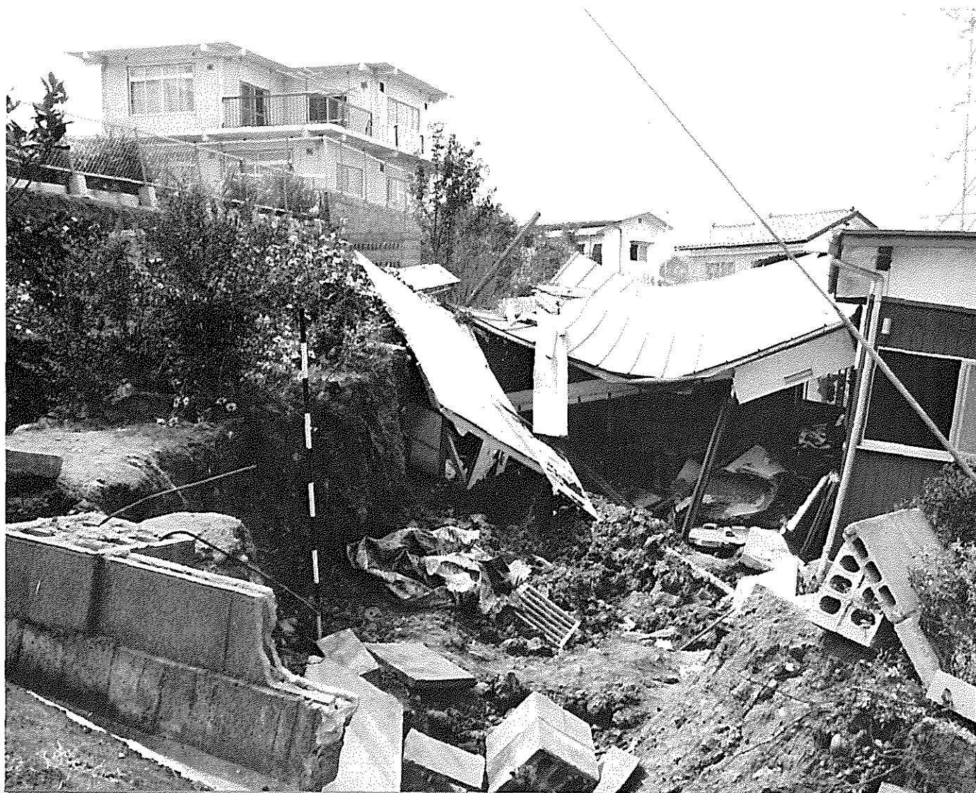
盛土造成された宅地が崩壊し、住宅が全壊した。(仙台市緑ヶ丘三丁目)
