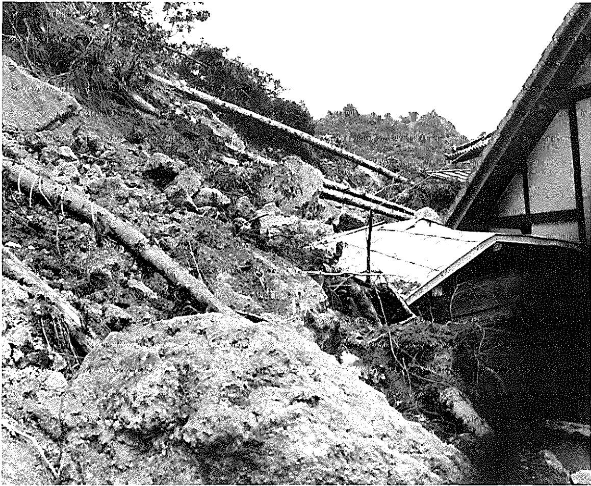
凝灰角礫岩が延長約八五mにわたって約二、〇〇〇m 3 が崩落し、住宅四戸が半壊した。(松島町高城字愛宕)
