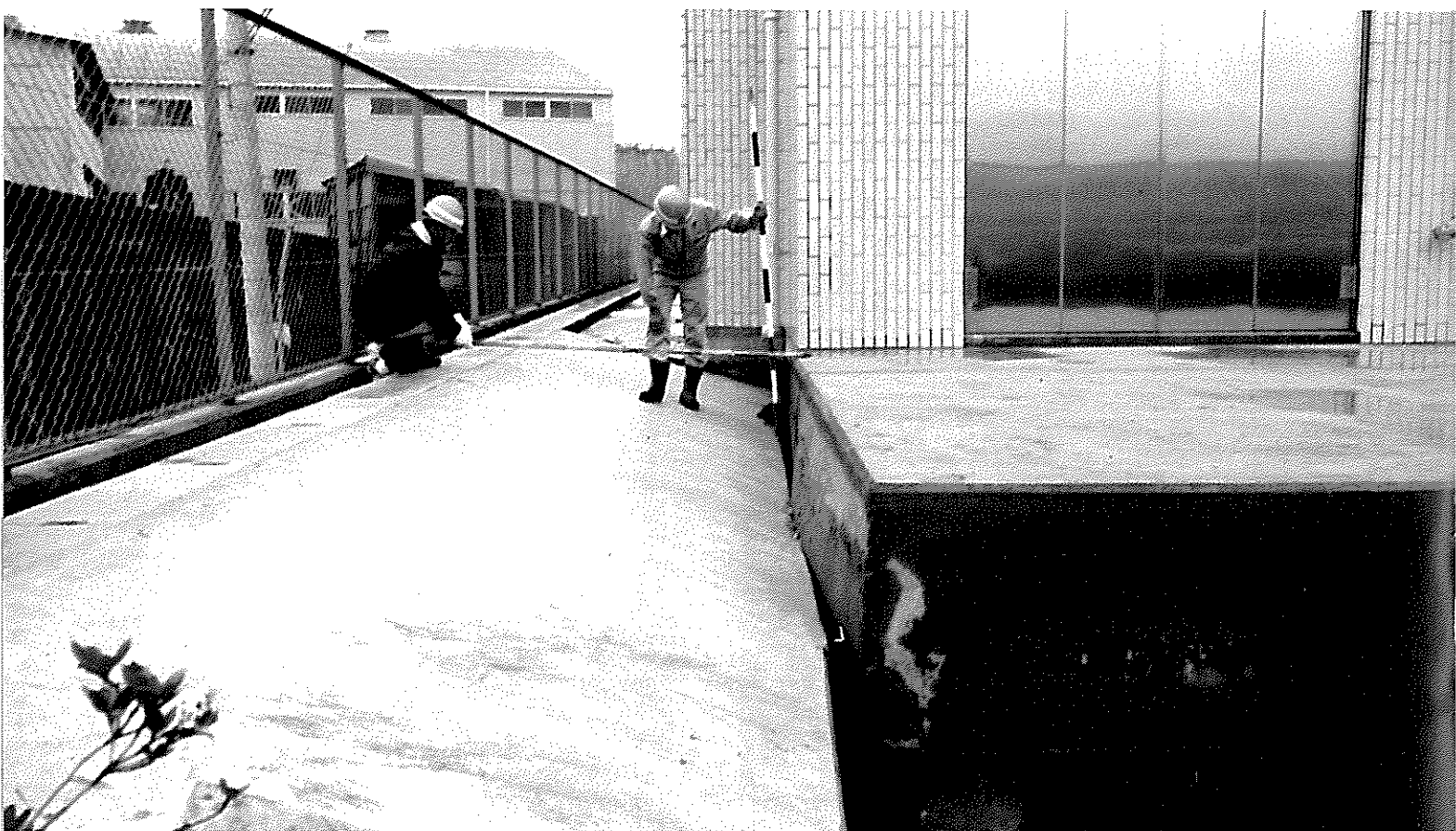
ポンプ場内叩きコンクリート版の沈下破損(塩釜市・仙塩流域下水道塩釜中継ポンプ場)
