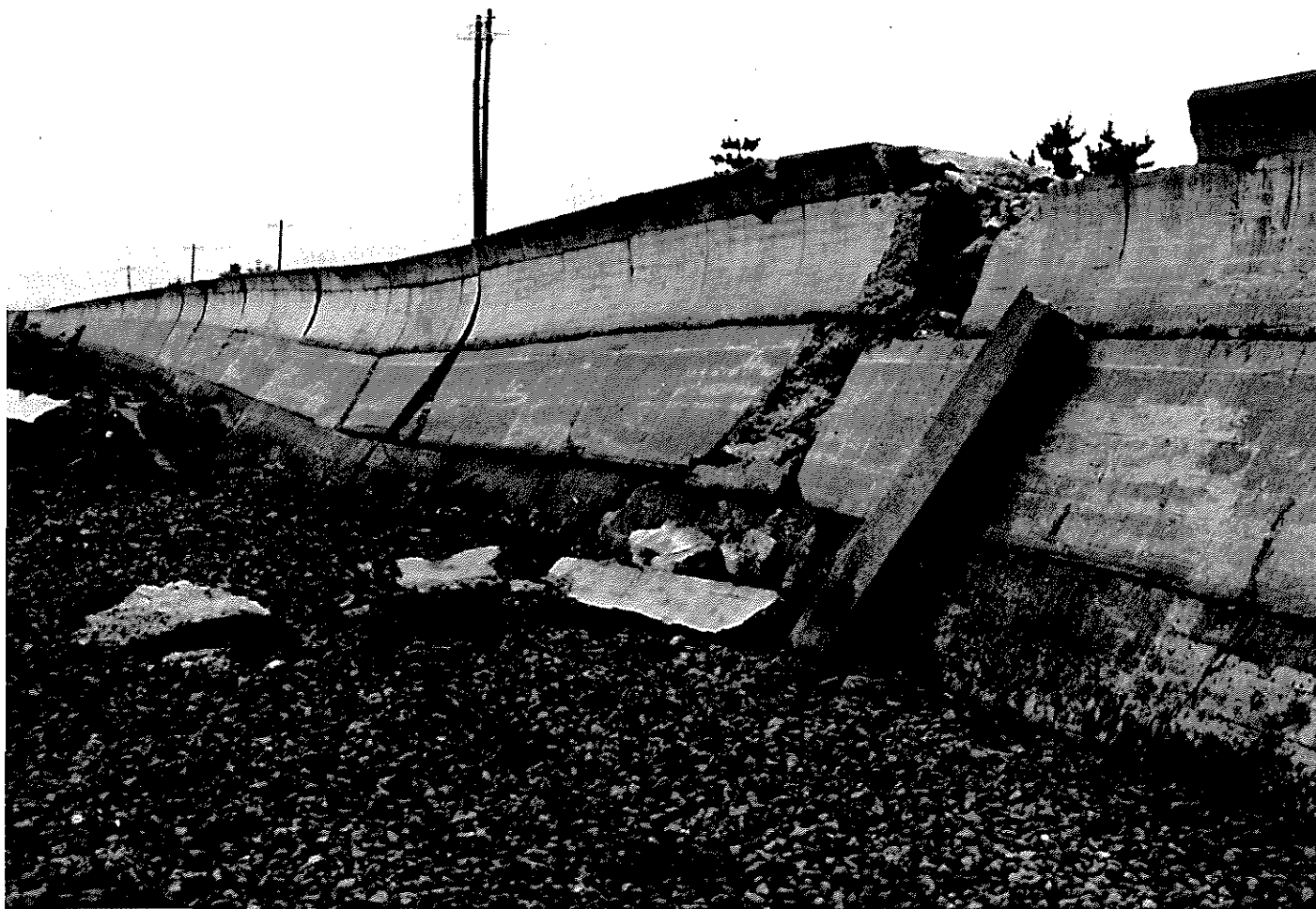
三面張海岸堤防の沈下と破壊（東名海岸・鳴瀬町洲崎）
