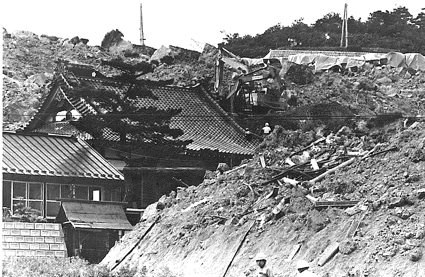
崩土は、寺院、住宅、道路を襲い、死者1名、住宅全壊1棟、道路欠壊約700m そして寺院1棟が半壊した。(白石市寿山・緑ヶ丘団地)
