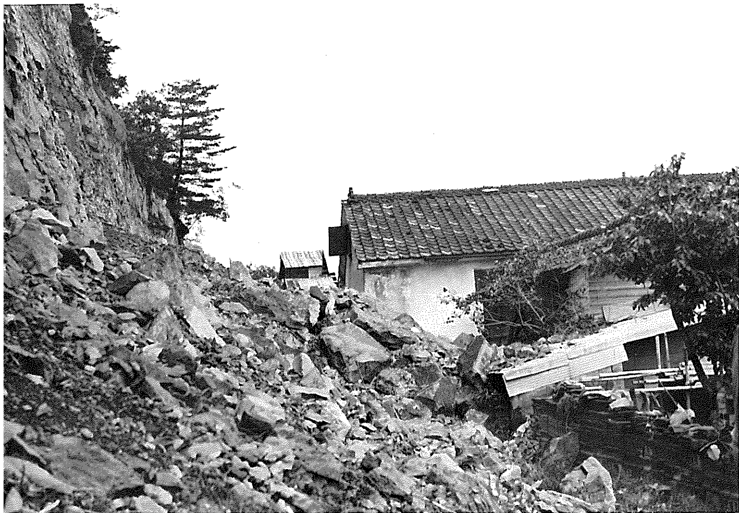
傾斜のきつい凝灰質シルト岩が延長110mにわたり崩落し、住宅半壊1戸、一部破損1戸の被害となった。(三本木町蛇沼山地区内)
