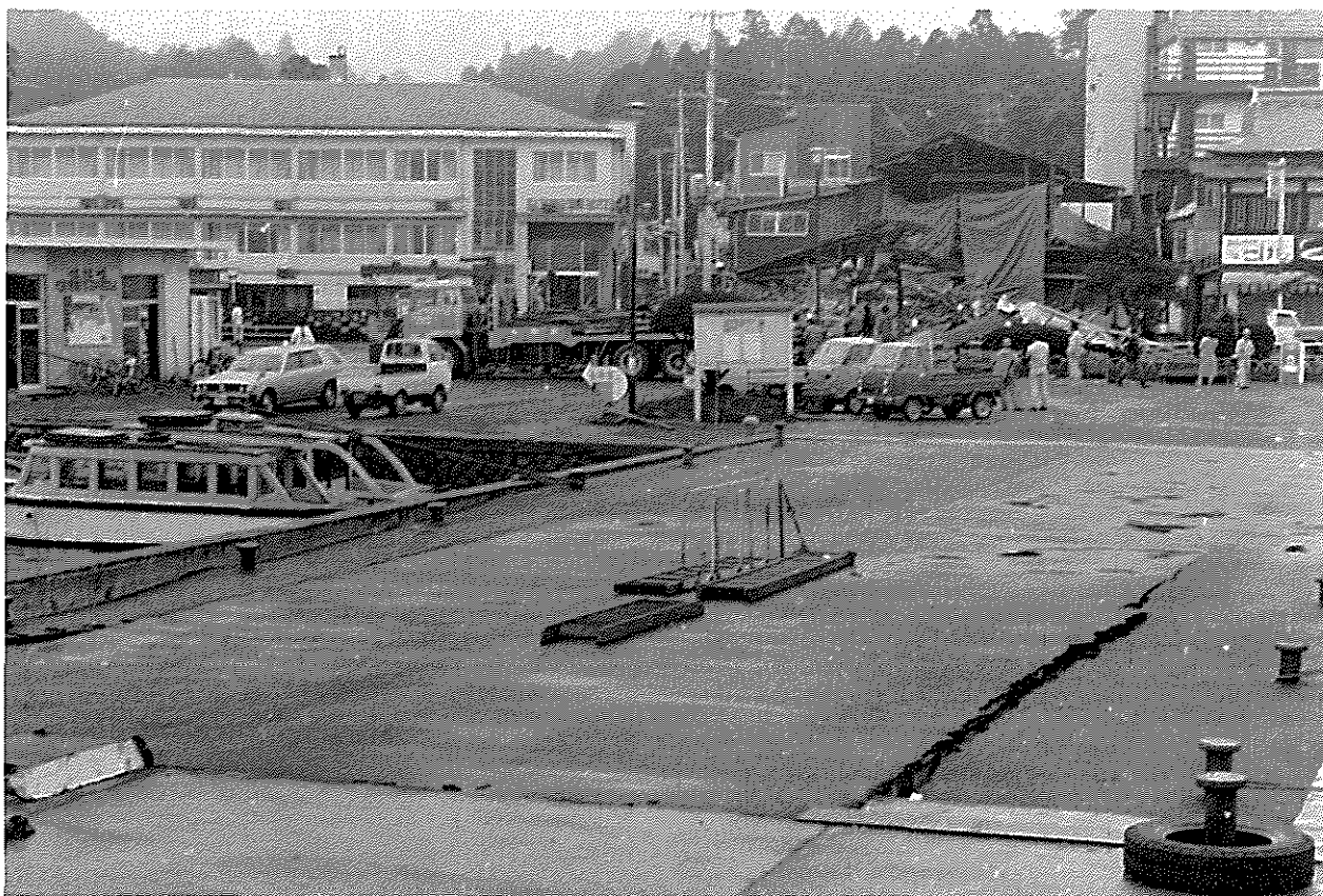
松島港観光棧橋のエプロンの沈下（地方港湾松島港）
