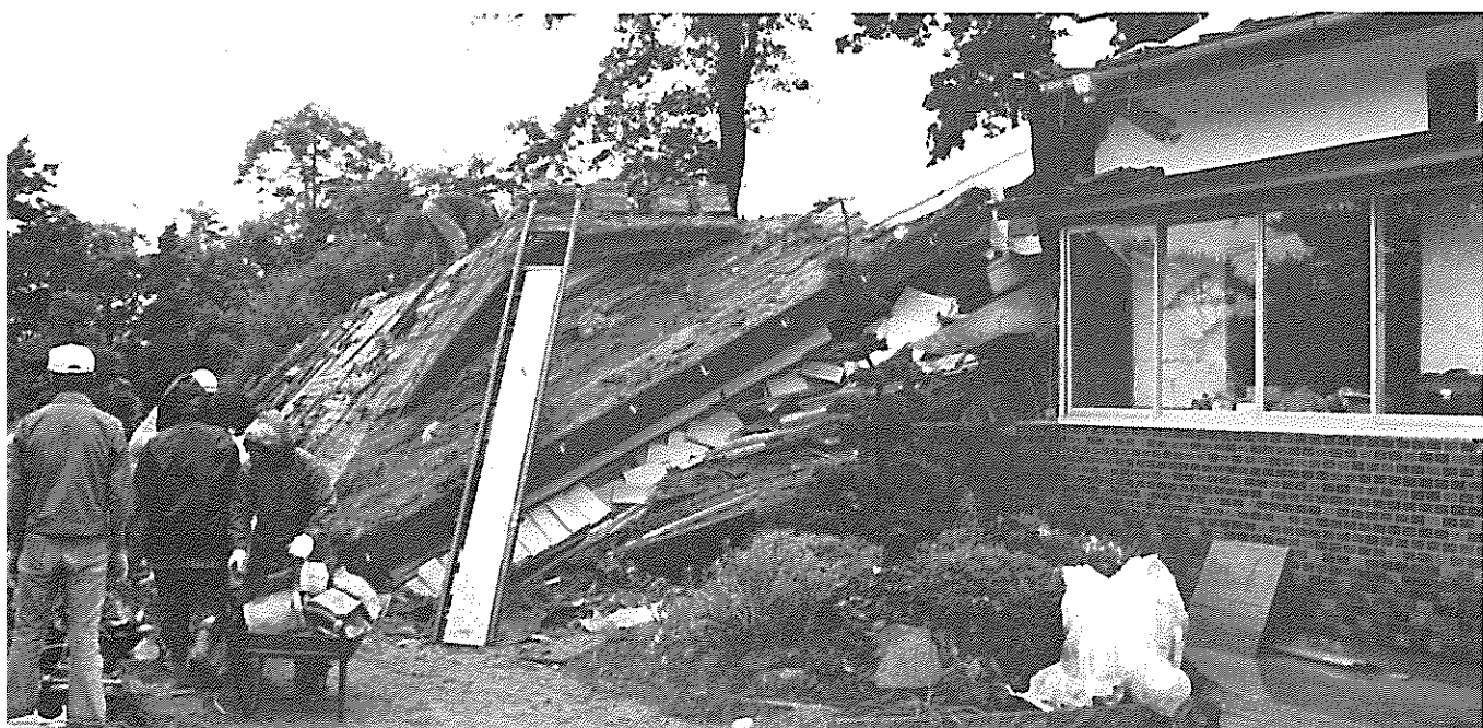
瓦屋根など屋根の重いものも倒壊が多かった。(小牛田町)
