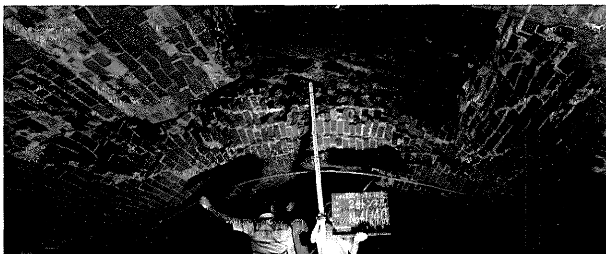
3層から6層のレンガで巻いた河川トンネル覆工部の亀裂と崩落（高城川・松島町泉ヶ原）
