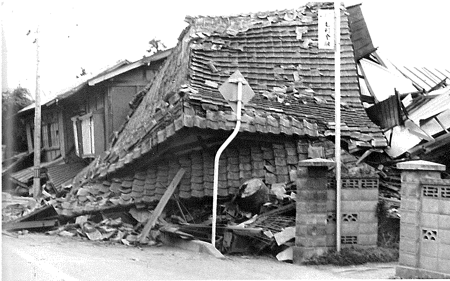
古い木造住宅に倒壊が多かった（米山町）
