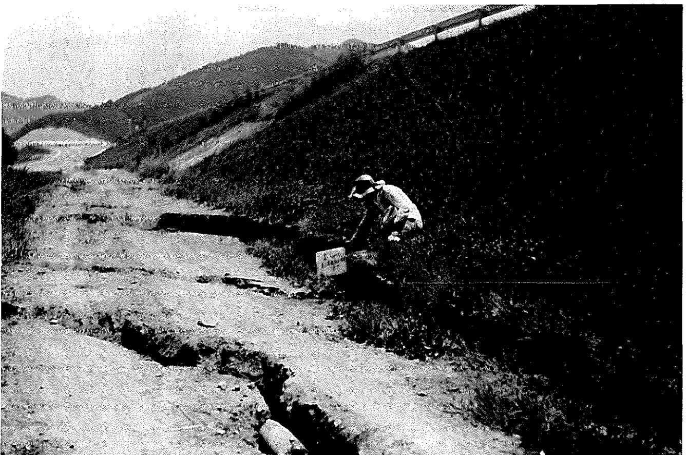
裏小段にも亀裂や段差が生じている。（北上川左岸・橋浦堤防）
