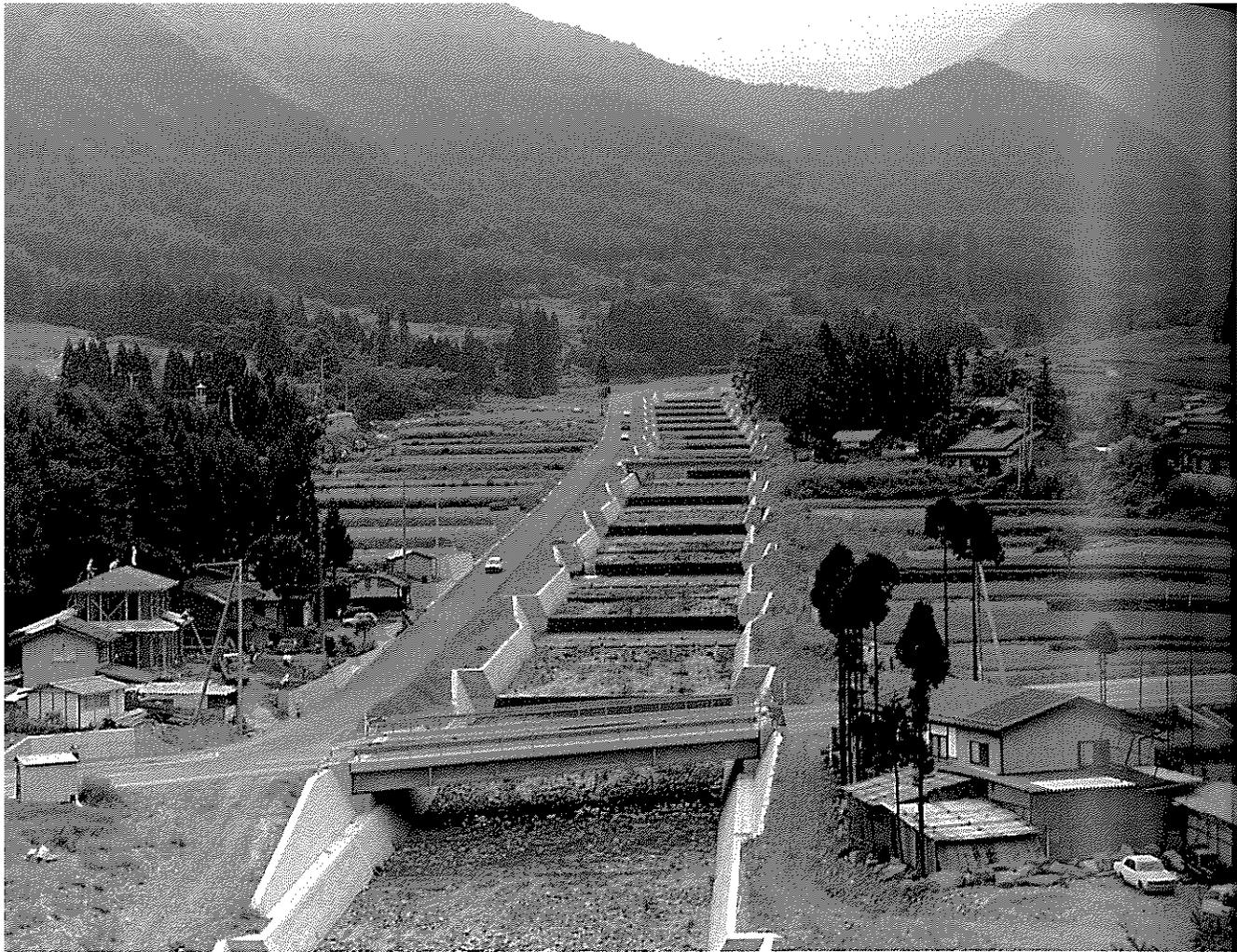
復旧工事が完成し、見違えるようになった宇原川、国道406号線宇原橋上流
