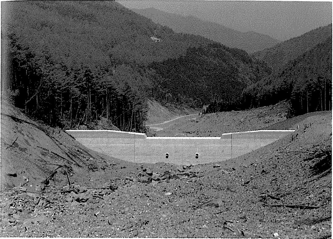
緊急治山事業により、谷止工が完成、ロット沢に五基建設される
