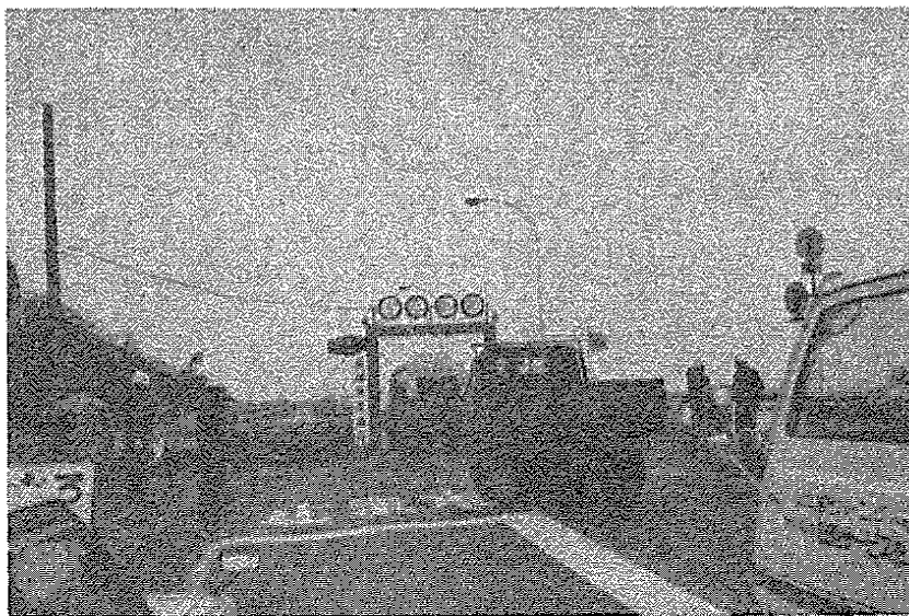
写真-1 静内橋交通規制状況
