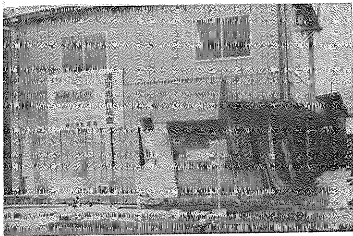
写真 2-7 浦河町内の住宅被害
